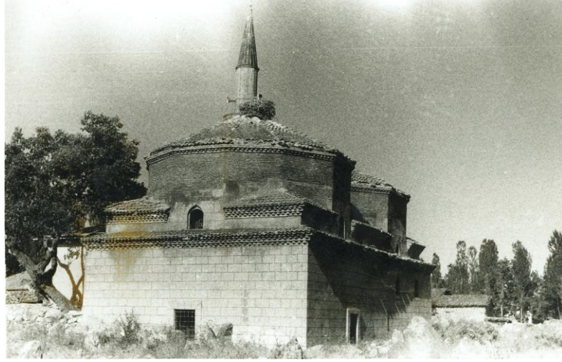
Resim 8- Türbe yapımında taş ve tuğla kullanımına diğer bir örnek. (Vakıflar Genel Müdürlüğü Arşivinden)
