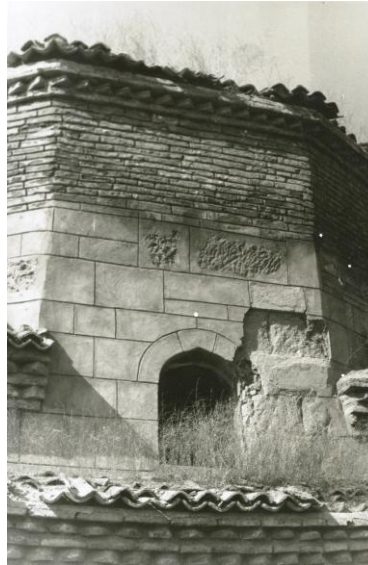
Resim 7- Türbe yapımında taş ve tuğla kullanımına örnek. (Vakıflar Genel Müdürlüğü Arşivinden)
