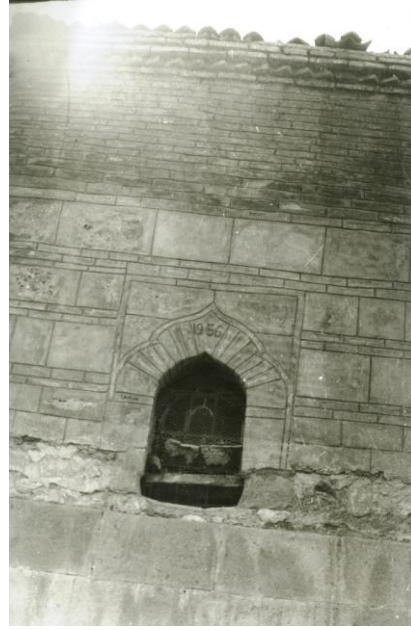
Resim 12-Caminin kubbe kasnağındaki güneye açılan penceresinin kilit taşı. (Vakıflar Genel Müdürlüğü Arşivinden)
