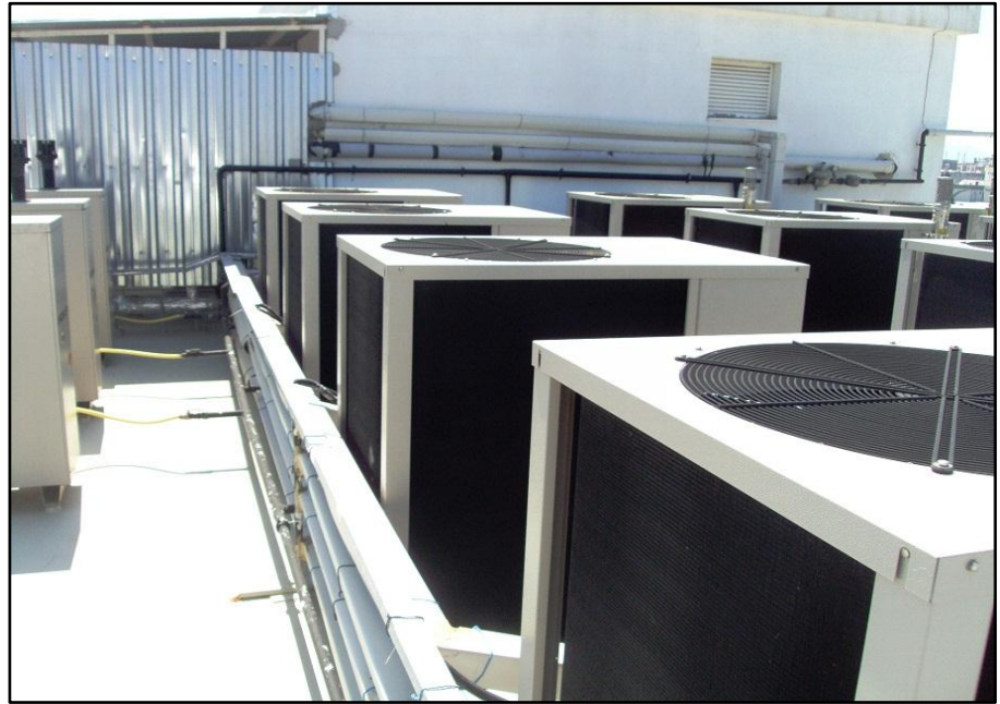
Şekil 4.9 Oteldeki dörtlü soğutucu düzeni
