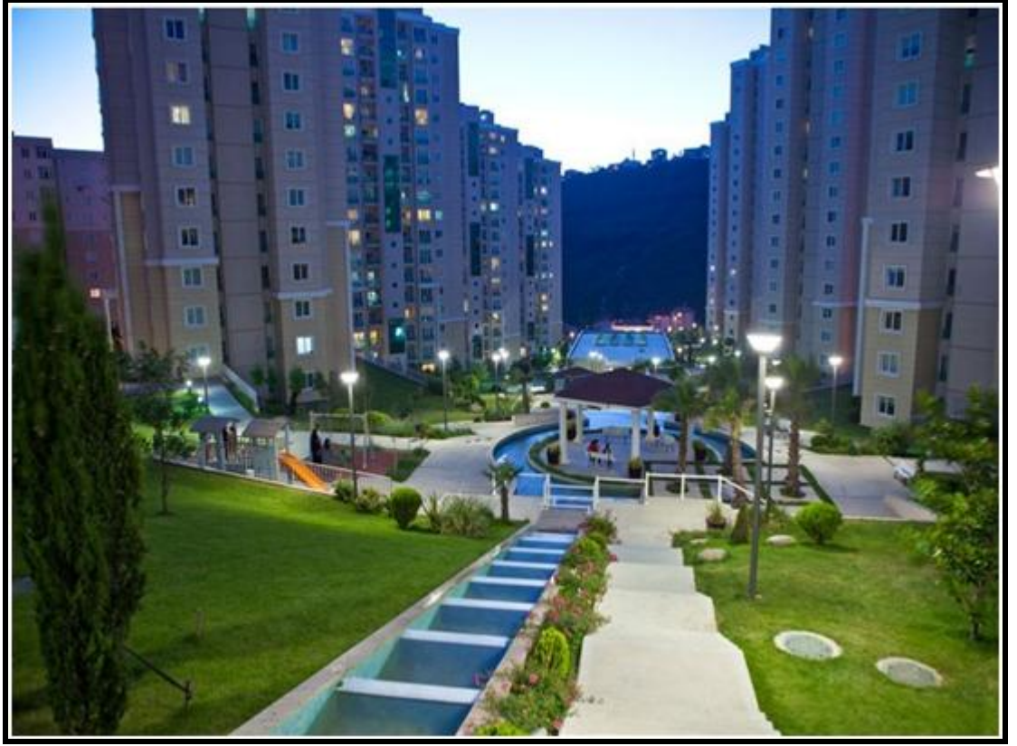
Şekil 4.2: Kiptaş Maltepe Evleri görünüşü.
