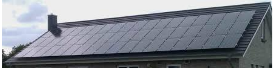
Şekil 1.1 Çatıya kurulu PV sistemin baca tarafından kısmi gölgelenmesi
