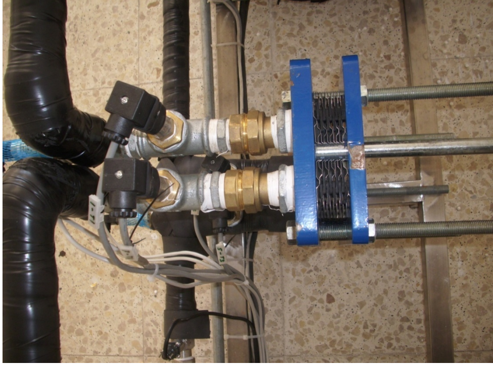
Şekil A.5. Plakalı ısı eşanjörü (üst görünüş)
