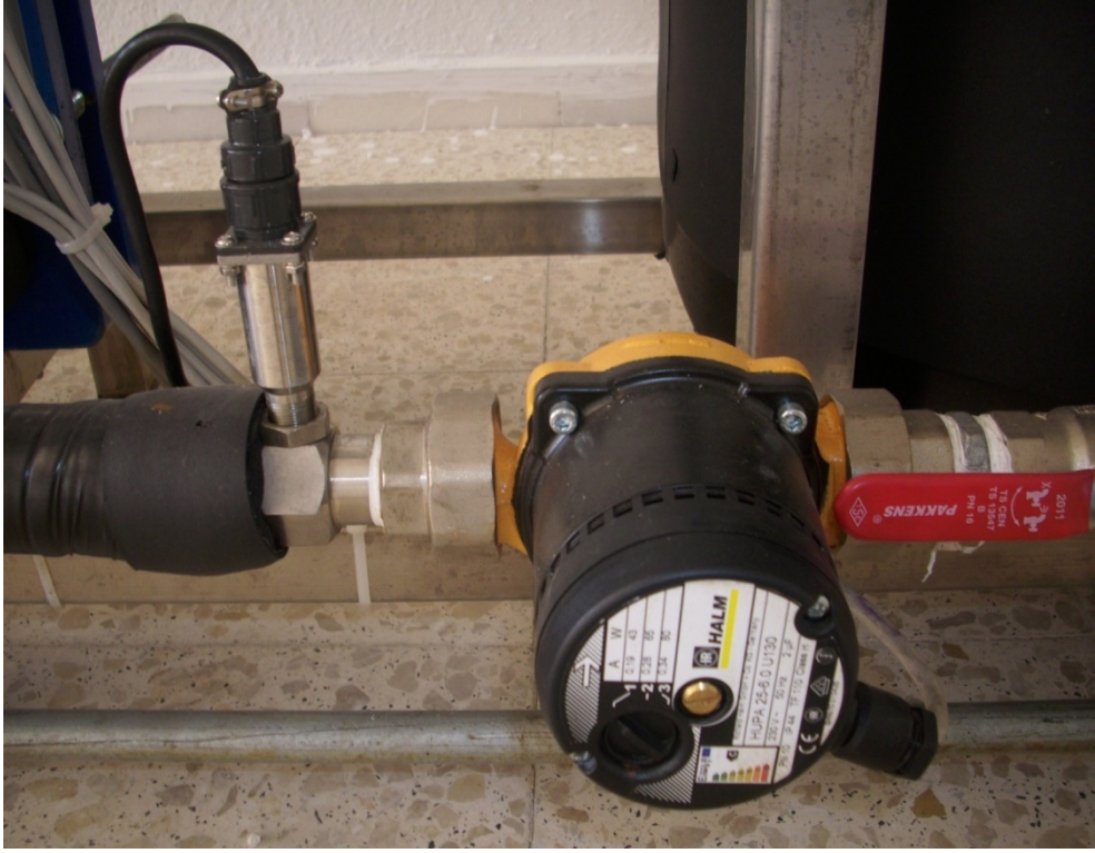
Şekil A.13. Akışkan devir-daim pompası (sekonder devre)
