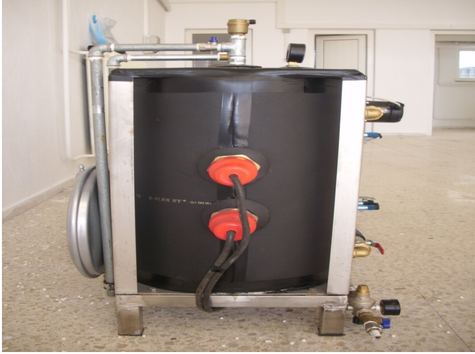
Şekil A.9. Sıcak su üretici kazanı (arkadan görünüş)
