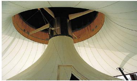
Şekil 4.7. Manzanares prototipinde kullanılan türbin
