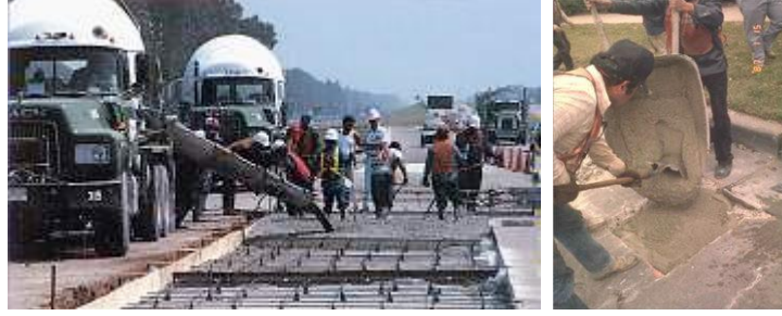
Şekil 2.10. Yol kaplaması onarım malzemesi olarak Amerika da Pyrament kullanımı
