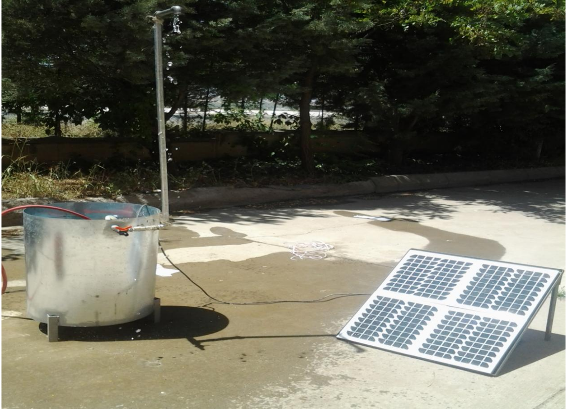
Şekil 2.1. Fotovoltaik PV sistem ünitesi
