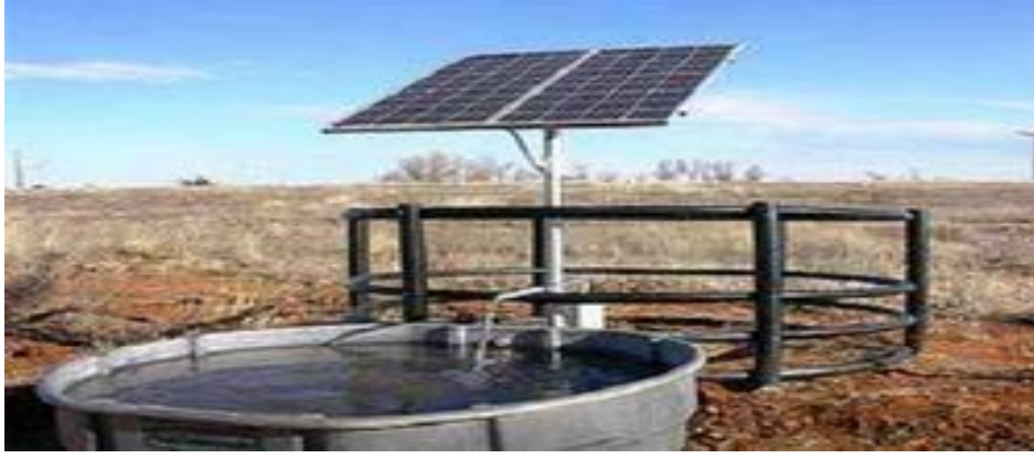
Şekil 1.12. PV su pompalama sisteminin bileşenleri
