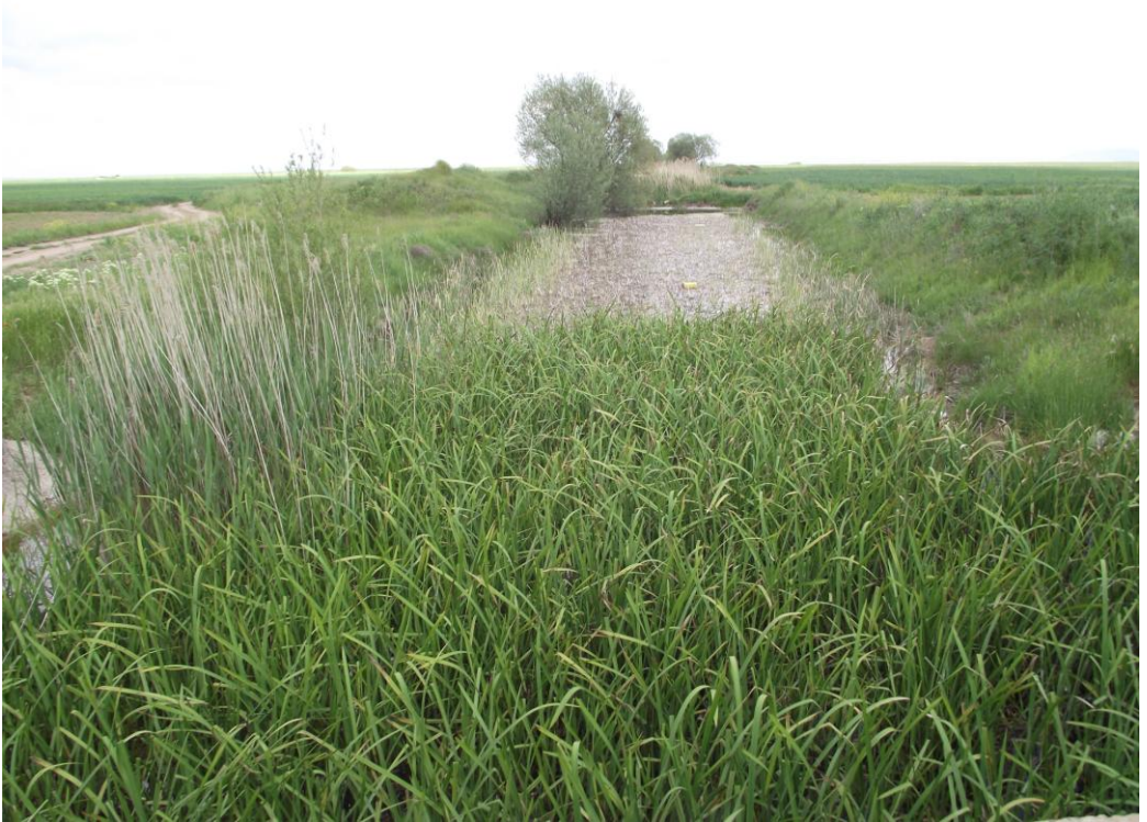
Foto 8. İptal edilen tahliye kanalı
