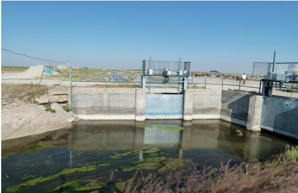
Foto 9. Malya DÜÇ de açılan tahliye kanallarındaki 1 ve 2 nolu kapaklar.
