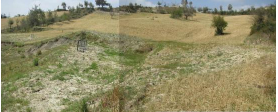
Şekil 4.5. BTC boru hattı güzergahında gelişen heyelan.
