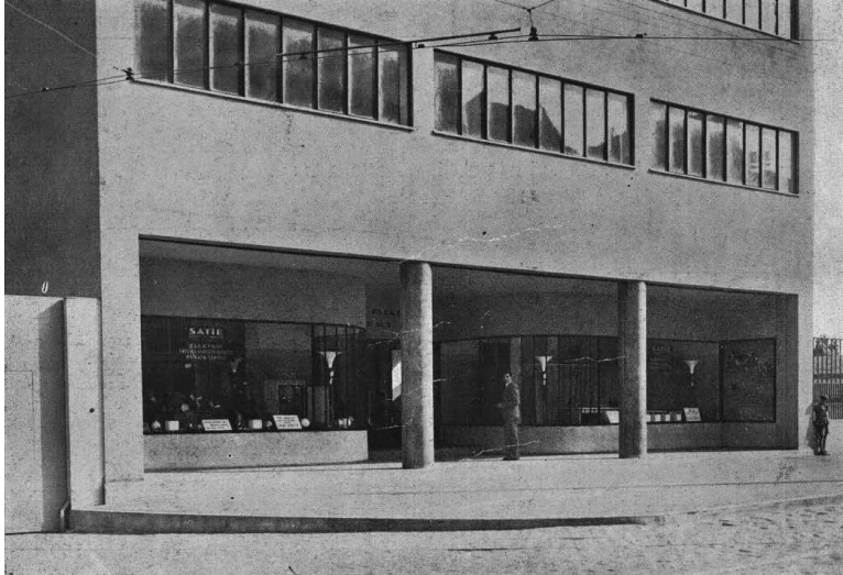
F.23: Sedad Hakkı Eldem, 'SATIE Binası', 1934, İstanbul
