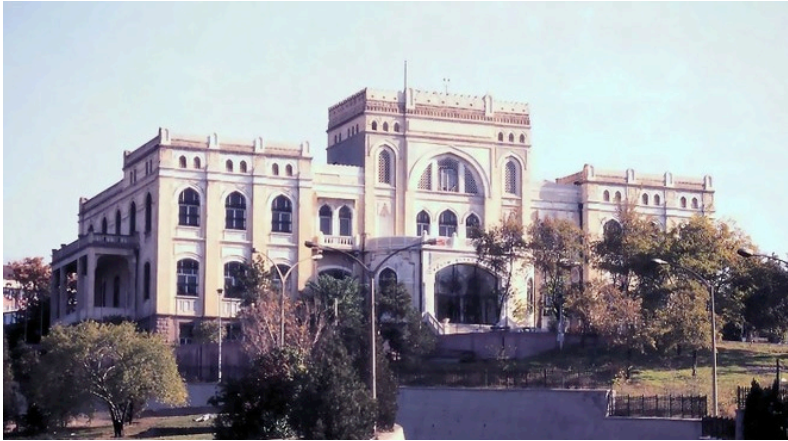
F.16: Arif Hikmet Koyunoğlu, ‘Türk Ocağı Binası’, 1930, Ankara.
