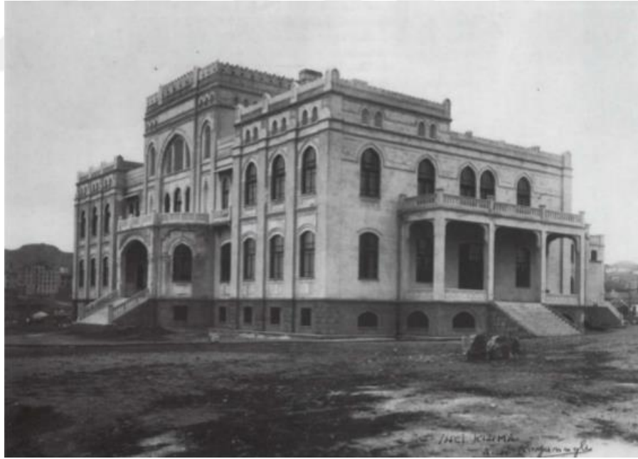
Resim 4. 1. İnşaatı Tamamlanan Türk Ocağı Binası.
