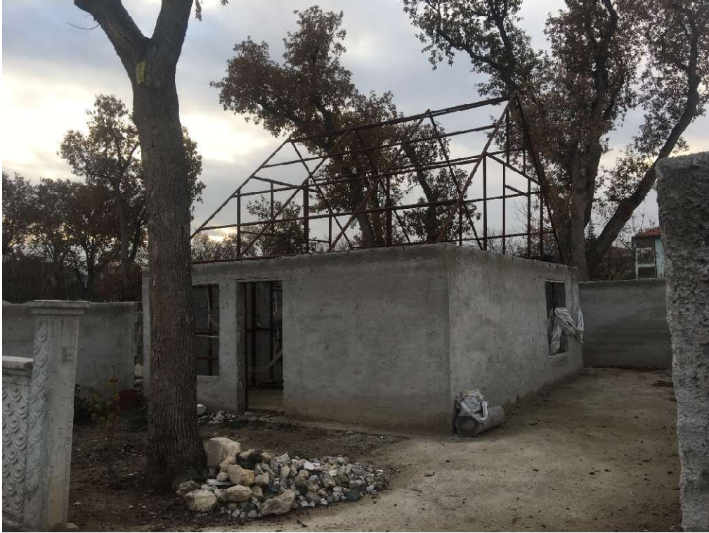
Şekil 5.1. Yapı fotoğrafı (Kişisel arşiv, 2022)
