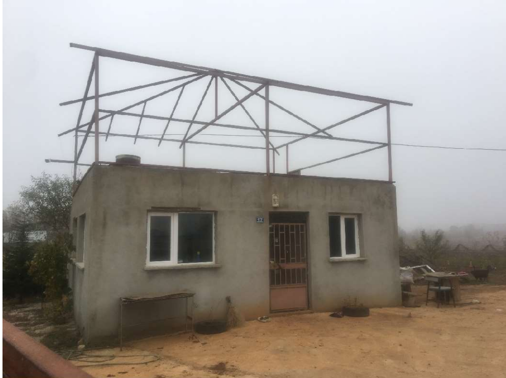
Şekil 5.3. Yapı fotoğrafı (Kişisel arşiv, 2022)
