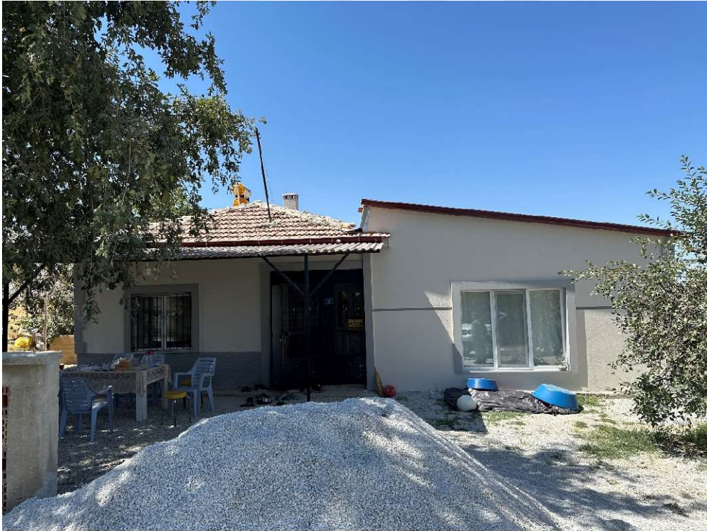
Şekil 5.6. Yapı ön cehpe fotoğrafı (Kişisel arşiv, 2022)
