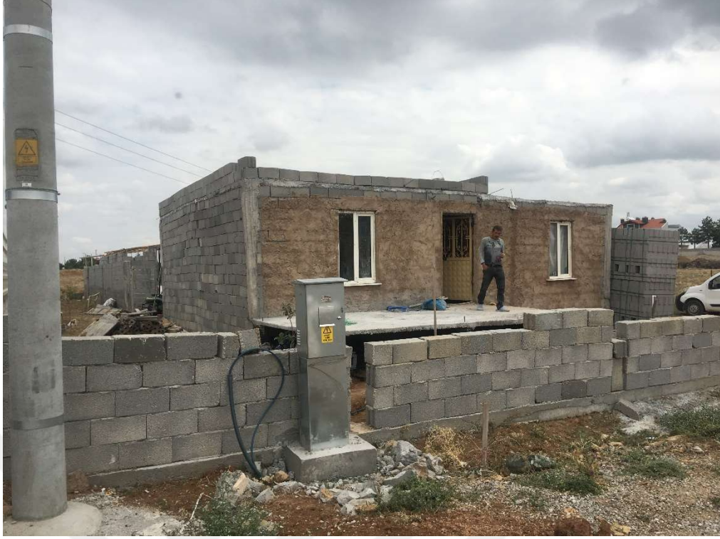
Şekil 5.2. Yapı fotoğrafı (Kişisel arşiv, 2022)
