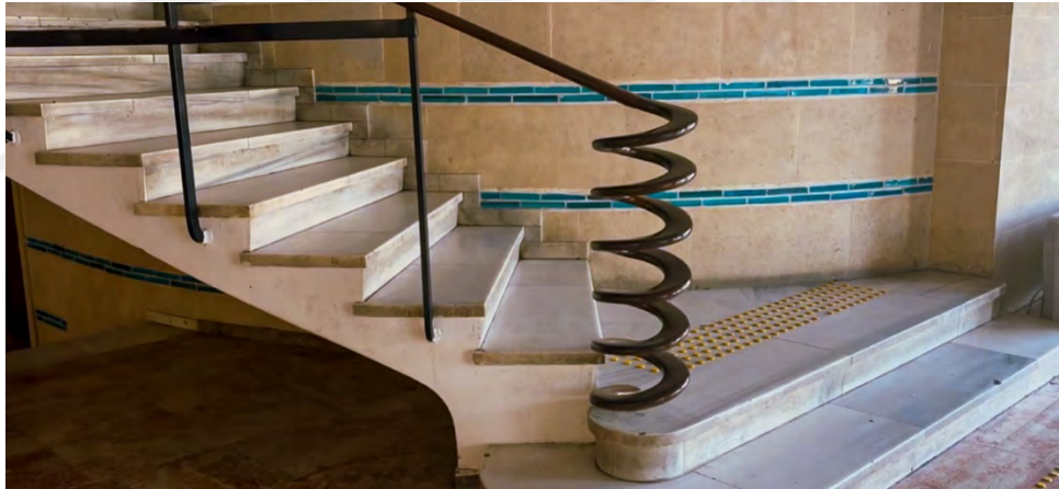
Şekil 42: DTCF Merdiven Detayı (Yazar tarafından çekilmiştir.)
