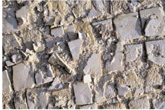
Resim 5.35. Tessera da yapraklaşmayı gösteren görsel
