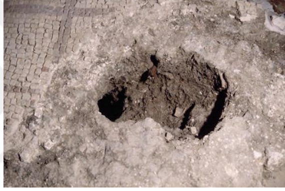
Resim 5.16. Mozaikli yüzeyde boşluk oluşumunu gösteren görsel
