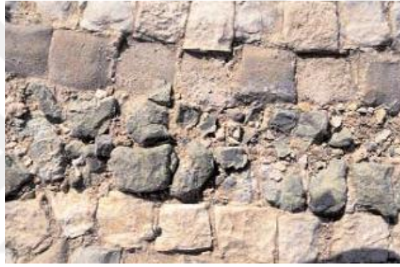
Resim 5.11. Mozaikli yüzeyde tessera kayıpları ve ayrılmalarını gösteren görsel
