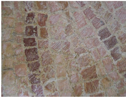
Resim 5.48. Hatalı mekanik temizlik uygulamasını gösteren görsel
