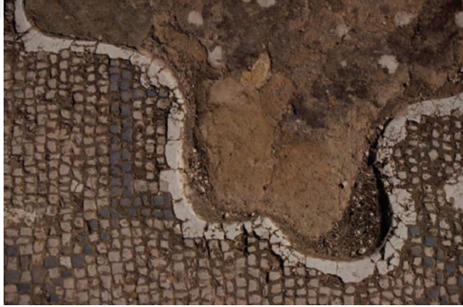
Resim 5.40. Özensiz işçilik olan bordür harcı uygulamasını gösteren görsel
