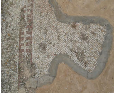
Resim 5.41. Uygun malzeme kullanılmayan bordür harcı uygulamasını gösteren görsel
