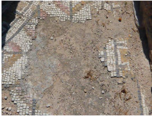
Resim 5.2. Mozaikli alanda lakuna oluşumunu
