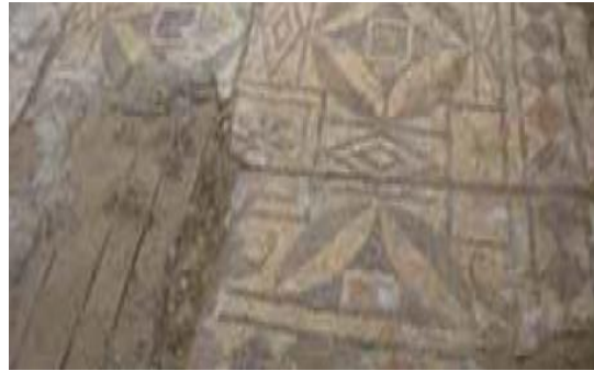
Resim 5.46 Taşıyıcıda yenileme uygulamasında hatayı gösteren görsel
