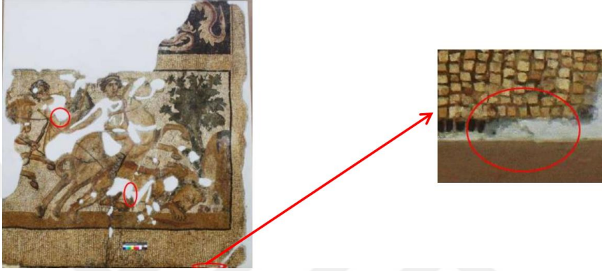
Resim 6.110 Onarım harçlarında yüzey-boya dökülmeleri ve detayı
