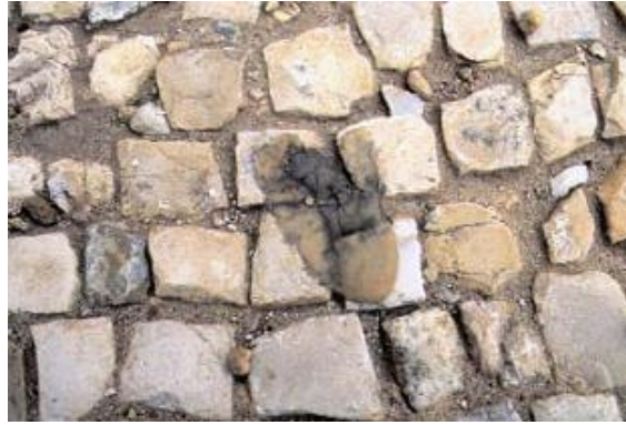
Resim 5.18. Mozaikli yüzeyde yüzeysel birikimi gösteren görsel
