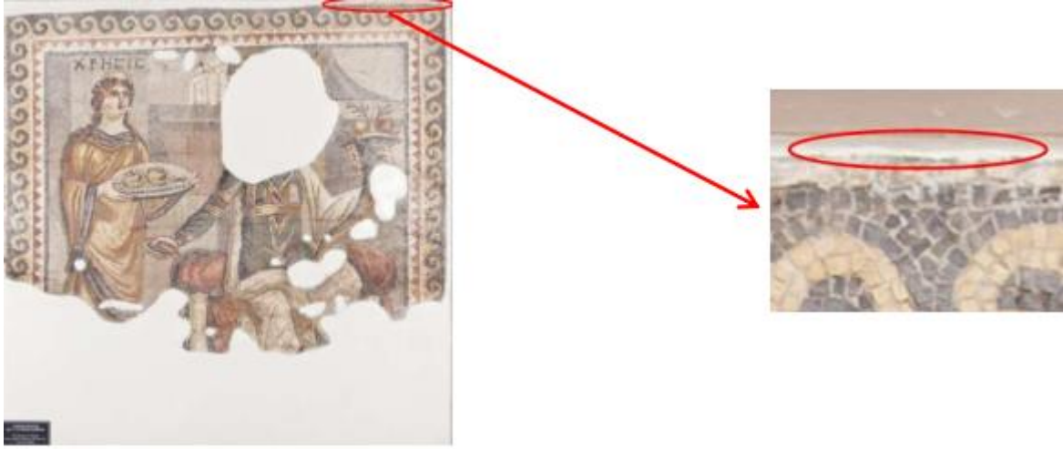
Resim 6.46. Onarım harçları ile taşıyıcı ayrılmaları ve detayı
