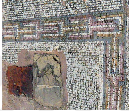
Resim 5.43. Malzeme açısından uyumsuz hatalı uygulamayı gösteren görsel
