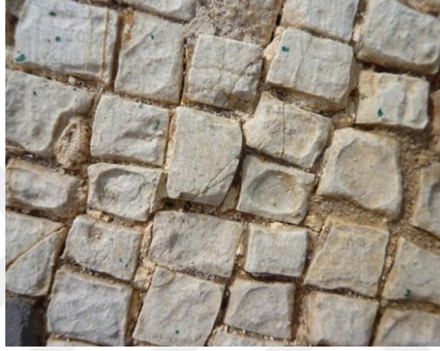
Resim 5.47. Hatalı kimyasal temizlik uygulamasını gösteren görsel
