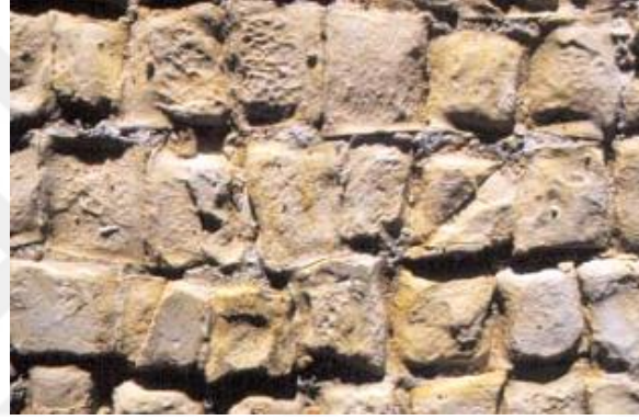
Resim 5.33. Tesseranın aşınmasını gösteren görsel
