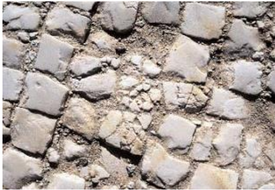
Resim 5.29. Tessera kırılmasını gösteren görsel
