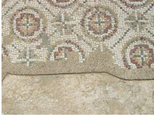
Resim 5.39. Amacını aşan bordür harcı uygulamasını gösteren görsel
