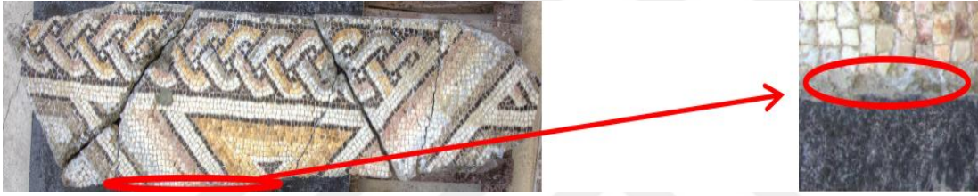
Resim 6.26. Çimento katkılı harç kullanımını ifade eden görsel
