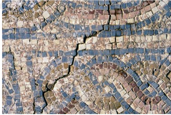
Resim 5.4. Mozaikli yüzeyde kırılma ve çatlama gösteren görsel
