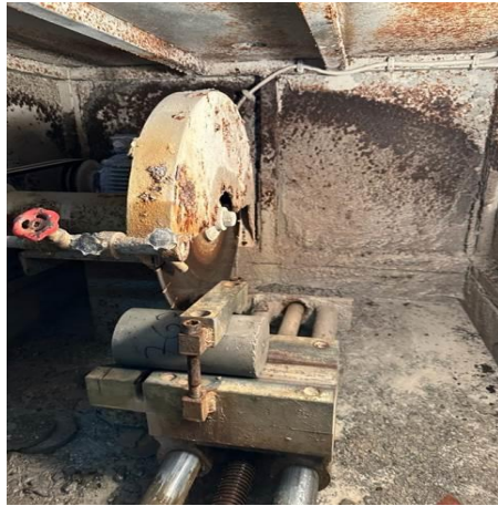
Şekil 3.10: Beton kesim işlemi
