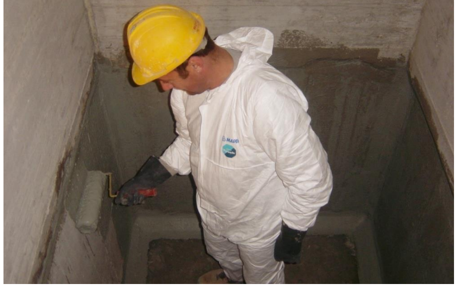
Şekil 2.16: Çimento esaslı su yalıtımı uygulaması (Mapei, 2024)
