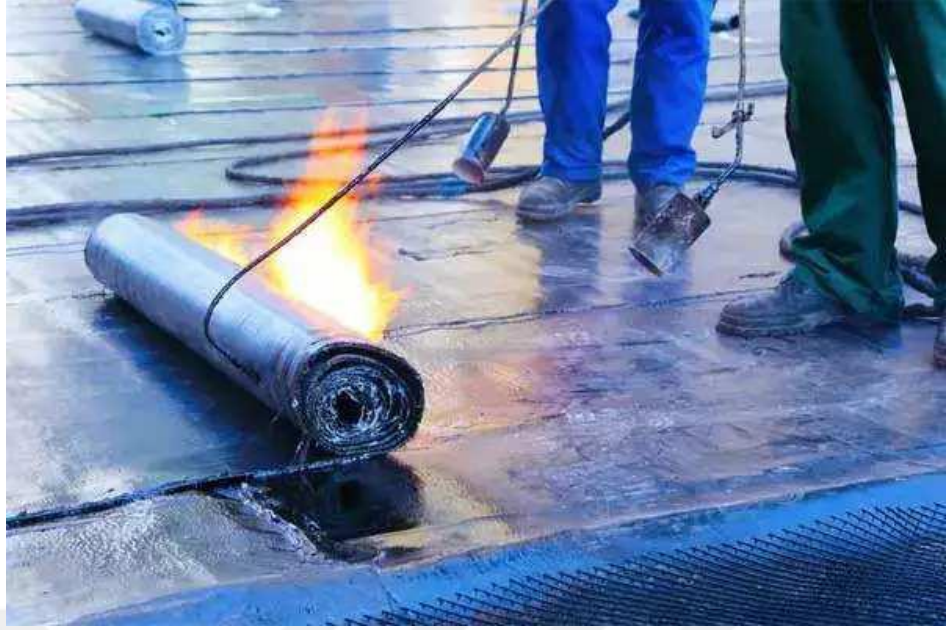
Şekil 2.20: Bitümlü membran uygulaması (İzoder, 2013)
