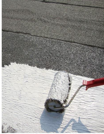
Şekil 2.19: Akrilik reçine esaslı su yalıtımı uygulaması (Mapei, 2024)
