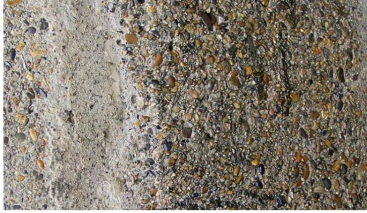
Şekil 2.5: Betonda aşınma örneği (Concept Concrete WA, 2019)
