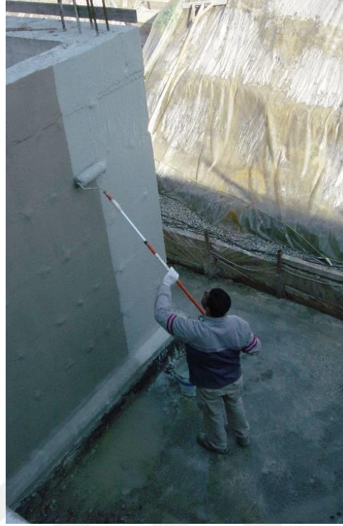
Şekil 2.15: Sürme tip su yalıtım uygulaması (Mapei, 2024)
