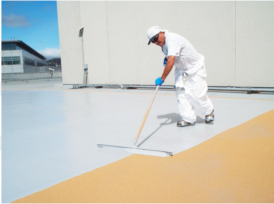
Şekil 2.18: Poliüretan esaslı su yalıtımı uygulaması (Mapei, 2024)
