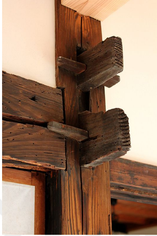
Şekil 1.1 Edo dönemine ait bir evde kullanılan sıkı geçme örneği [2]
