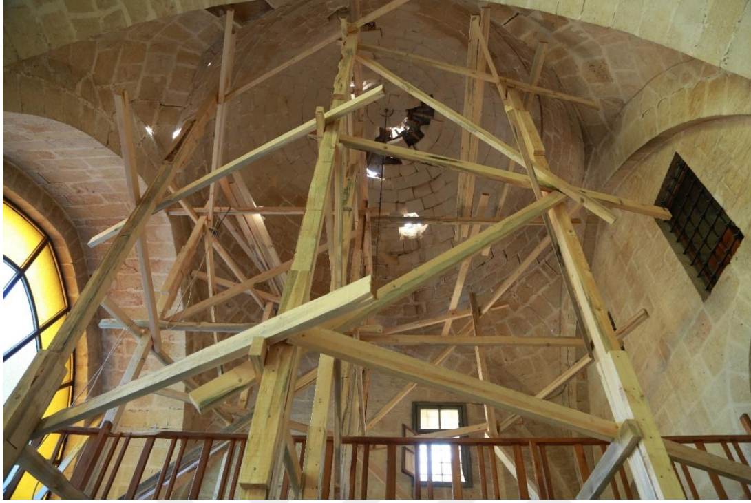
Resim 3.18. Hasar alan kubbeye güvenlik iskelesi uygulaması
