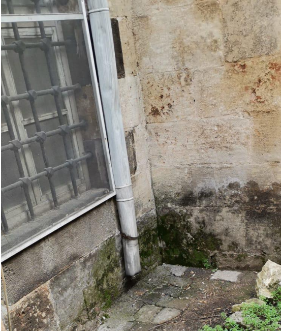
Resim 3.10. Güney cephedeki yağmur iniş borusu
