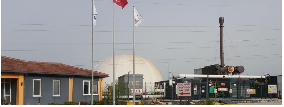
Şekil 4.13. Çarşamba Katı Atık Düzenli Depolama Tesisi
