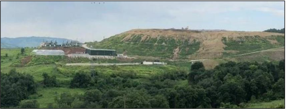
Şekil 4.12. Samsun Merkez Katı Atık Düzenli Depolama Tesisi
