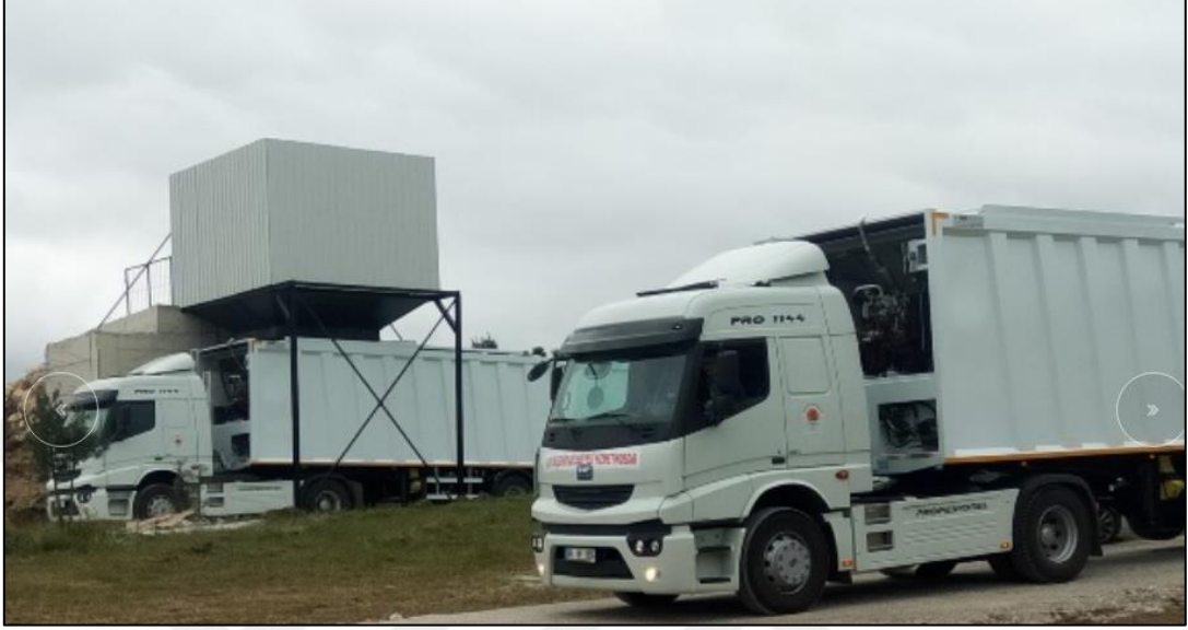
Şekil 4.16. Kavak Transfer İstasyonu
