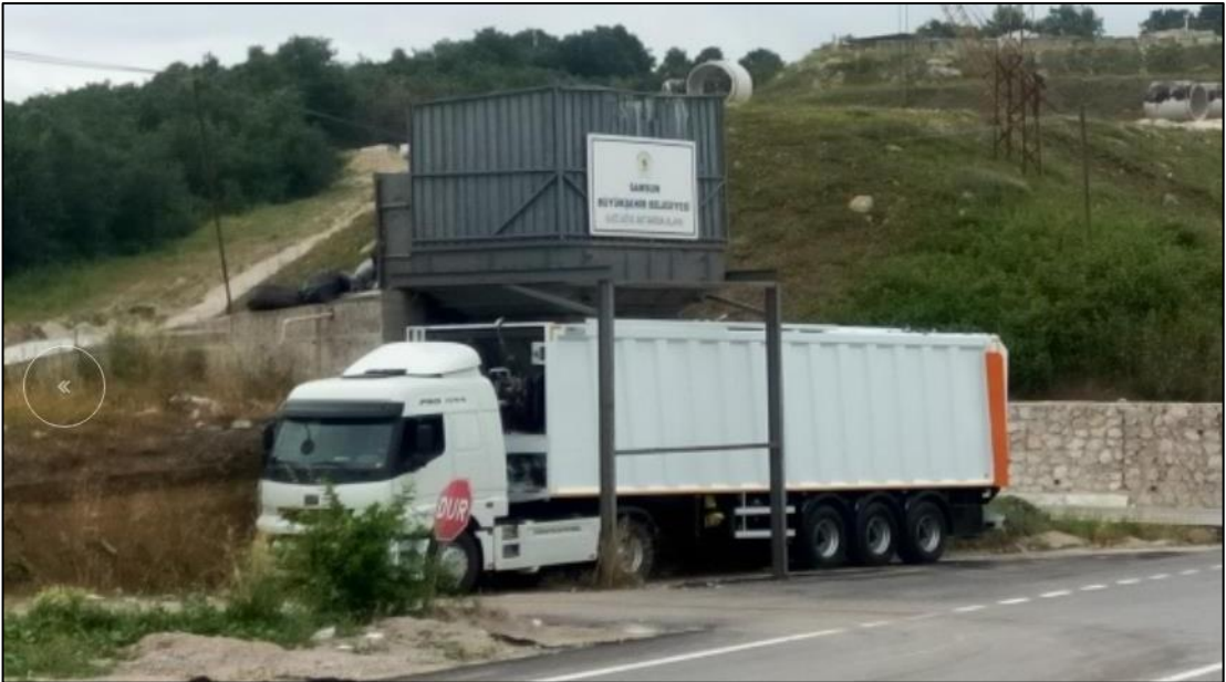
Şekil 4.17. Havza Transfer İstasyonu
