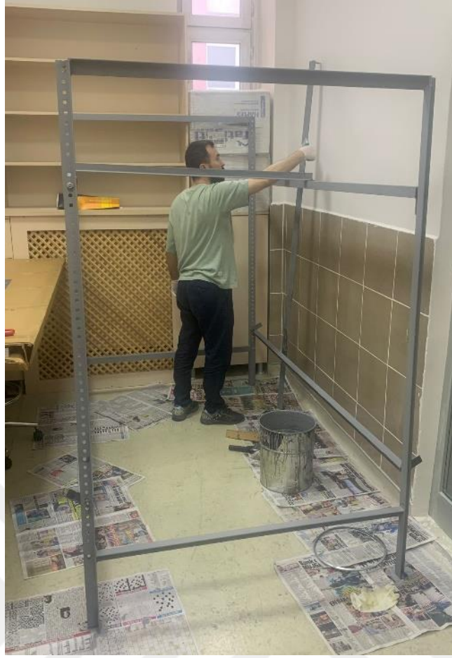
Şekil 14. PV panel, çatı malzemesi ve halojen projektörlerin yerleştirileceği demir standın son hali.
