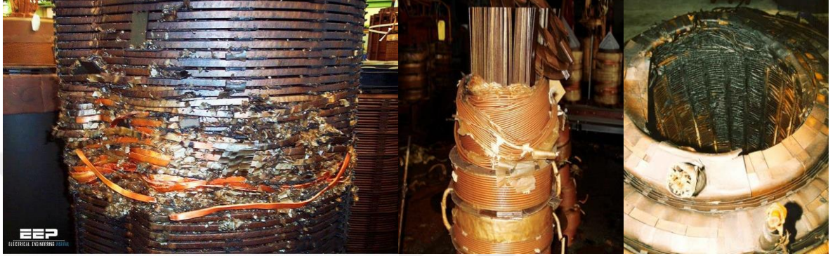
Şekil 3.13. Transformatörde sargı ve çekirdek arızalarının etkilerini gösteren görseller [58]
