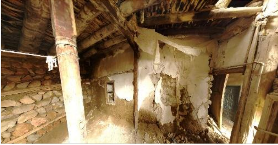
Resim 3.30. Z04 mekânı, doğu duvarı, alçı süsleme detayı
