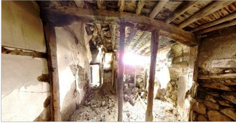
Resim 3.33. Z04 mahali güney duvarı
