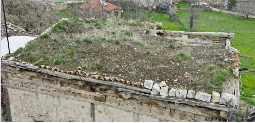
Resim 3.60. Aydınlı Evi çatısı detayı
