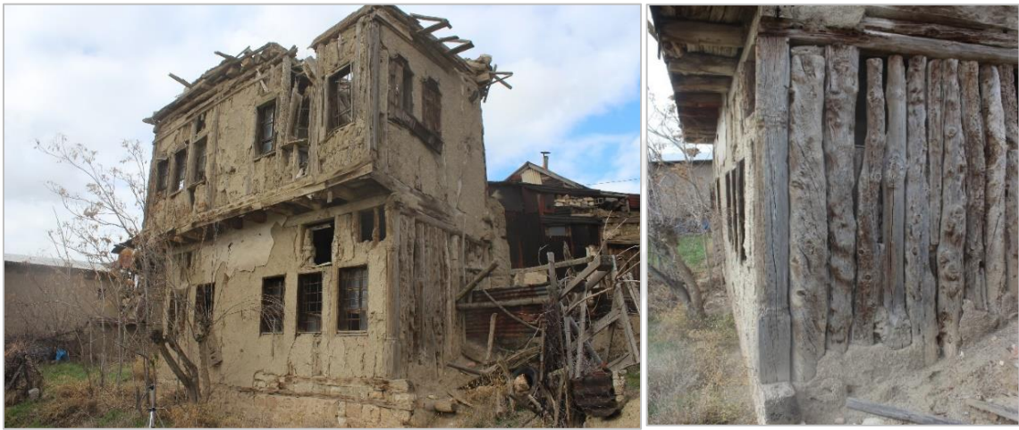
Resim 3.55. Z02 mahalinin doğu duvarı
