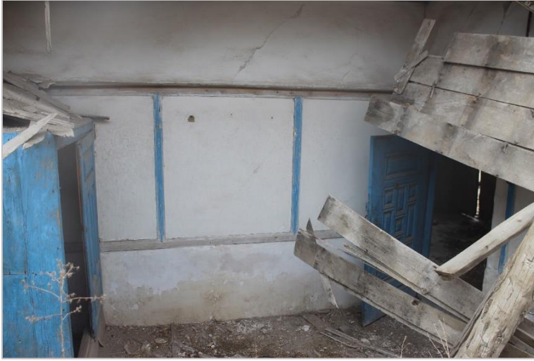
Resim 3.46. 103 nolu mahal batı duvarı ve giriş kapısı
