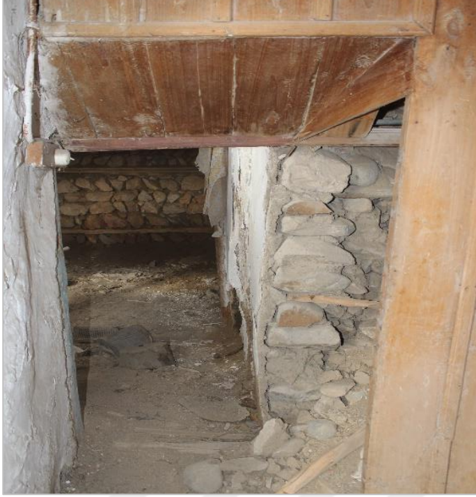
Resim 3.29. Z04'e geçişi sağlayan dikdörtgen formlu kapı açıklığı
