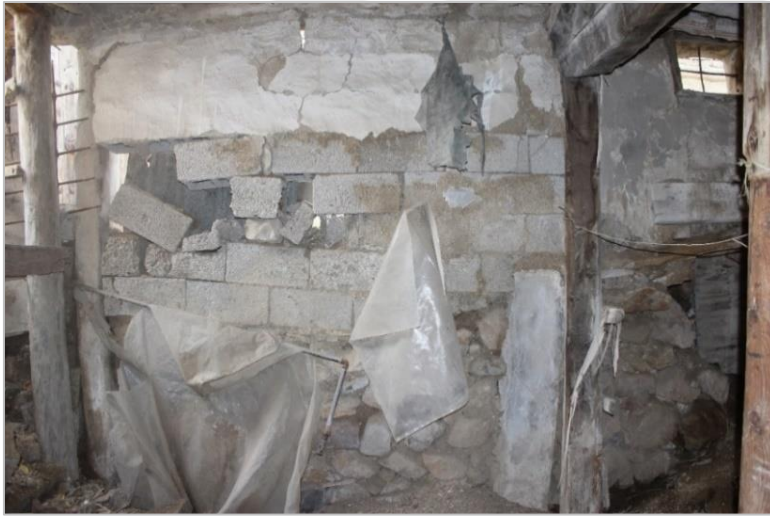
Resim 3.35. Z04 mahali, batı duvarı, tesisat detayı
