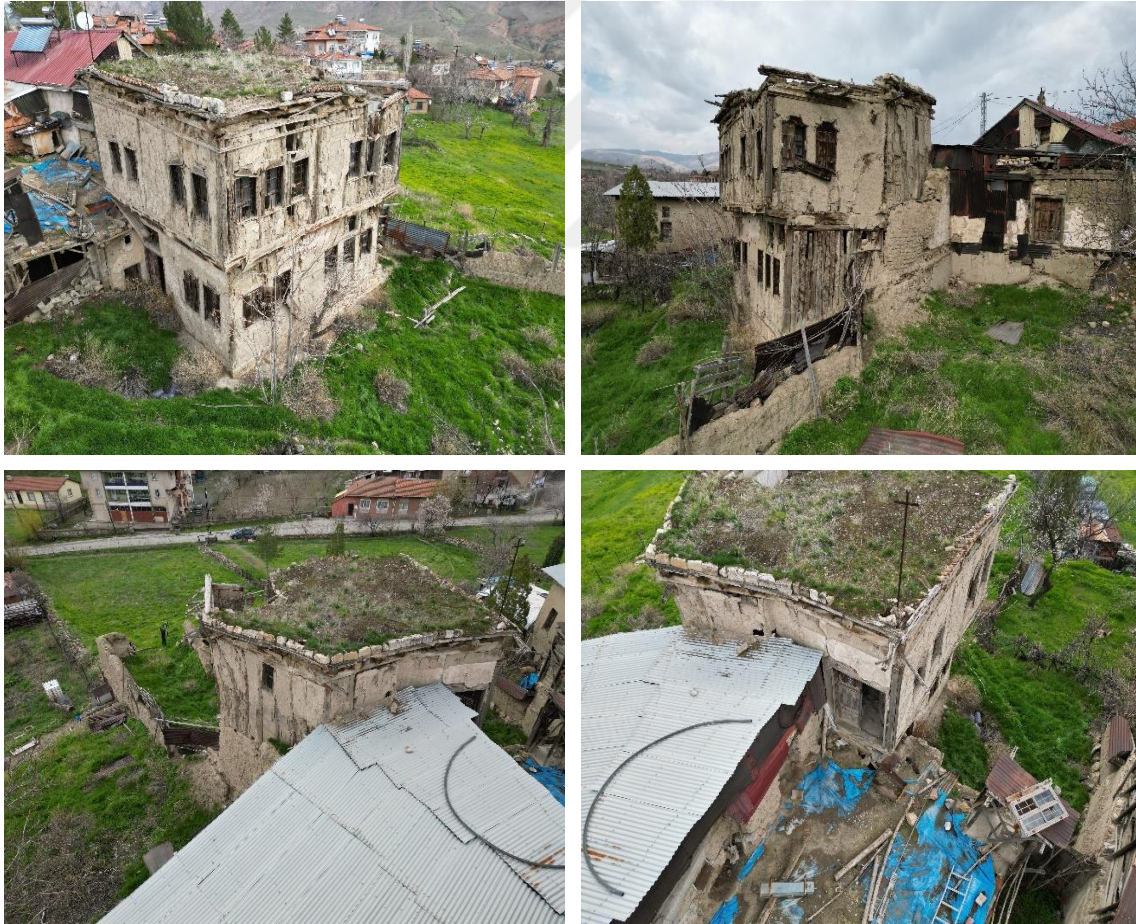
Resim 3.8. Aydınlı Evi; batı, güney, doğu, kuzey cephe genel görünümü
