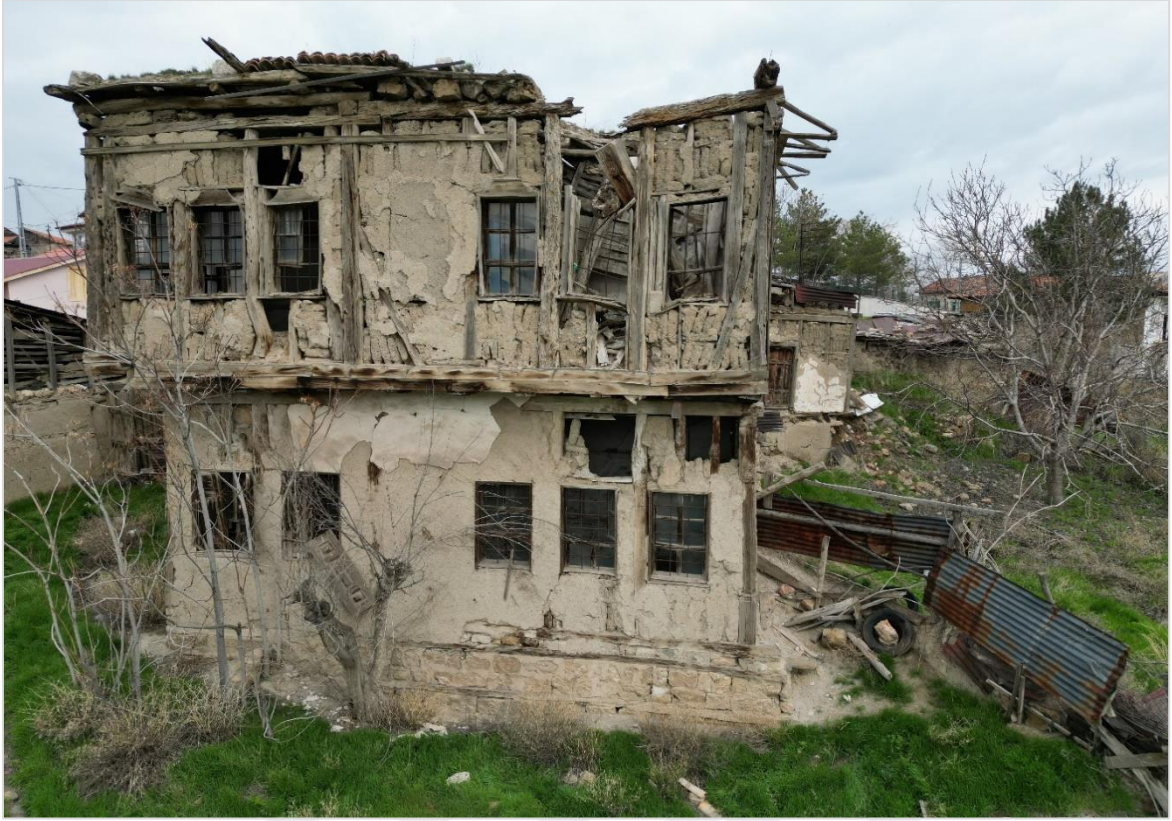
Resim 3.10. Aydınılı Evi, güney cephe
