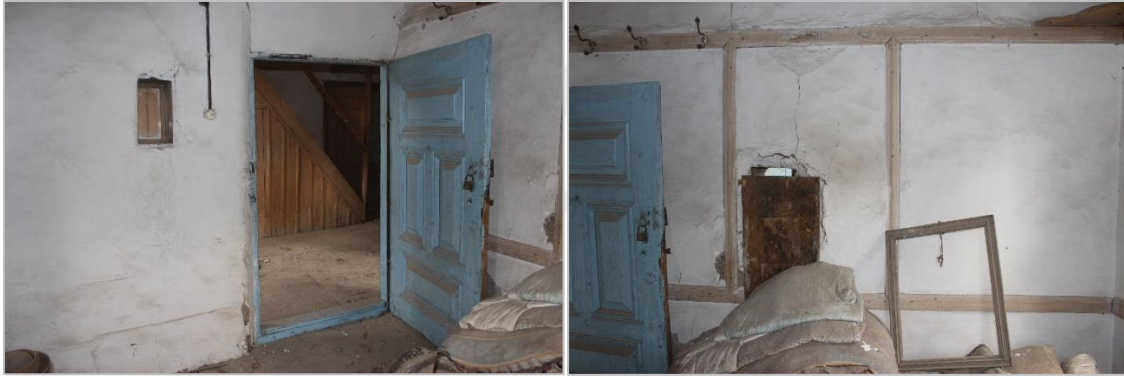
Resim 3.27. Z03 mahali kuzey duvarı ve doğu duvarı kapatılan pencere
