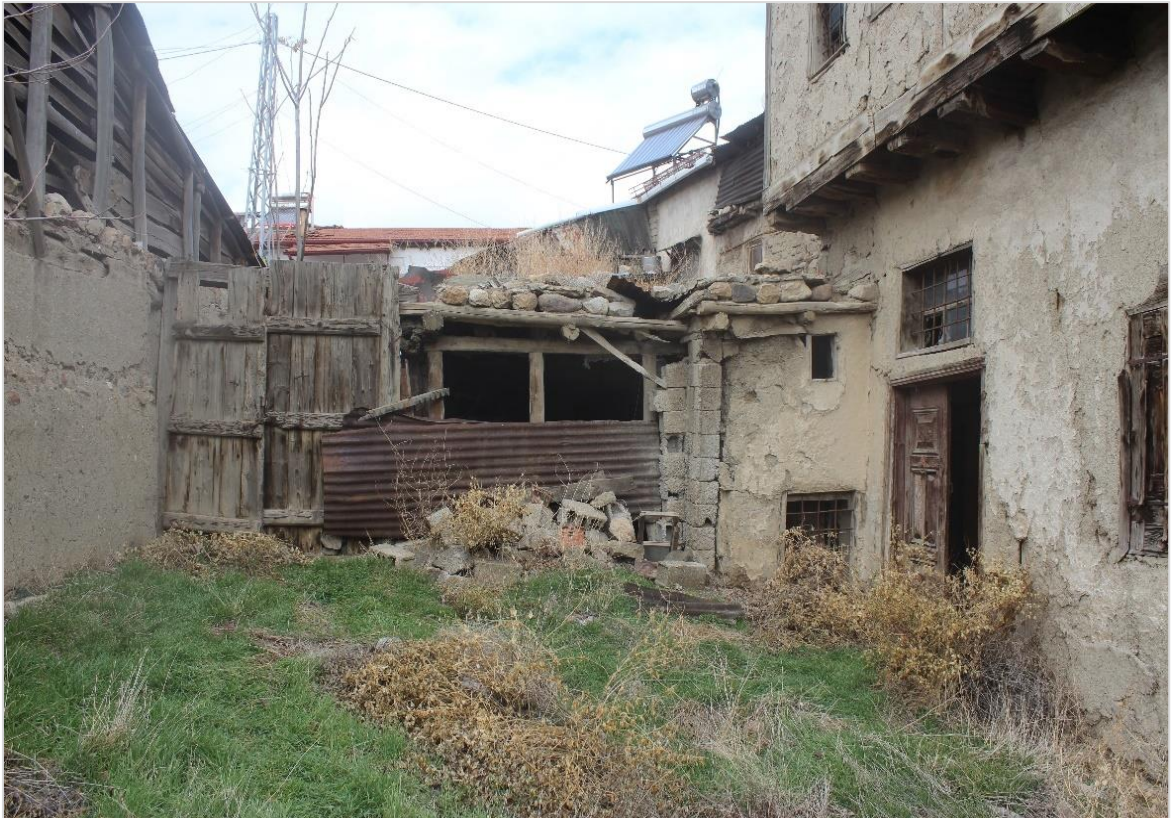
Resim 3.11. Aydınılı Evi, güney cephe
