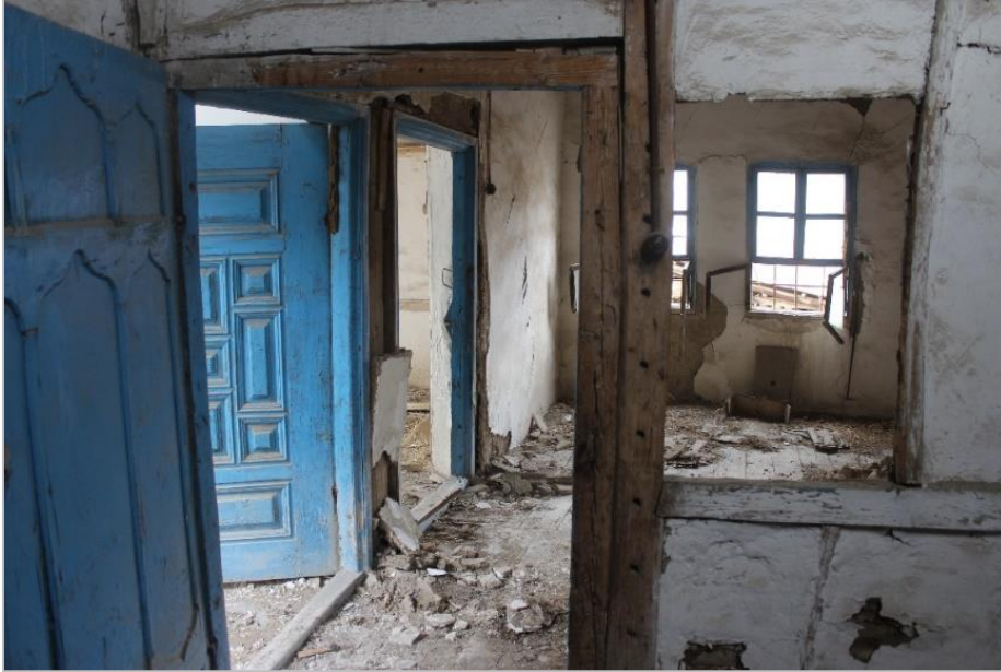
Resim 3.41. 102 nolu mahal batı duvarı
