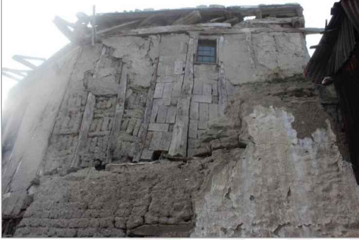
Resim 3.57. Doğu cephesinde bulunan briket, hımış, kerpiç duvar detayı
