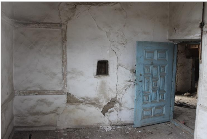
Resim 3.21. Z02 mahali batı duvarı
