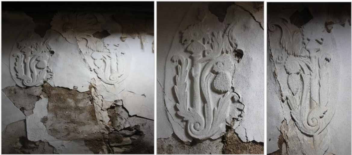
Resim 3.71. Aydınli Evi Z04 ocak etrafı alçı bezeme
