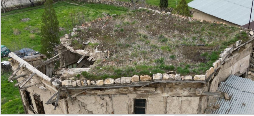
Resim 3.59. Aydınlı Evi çatısı detayı
