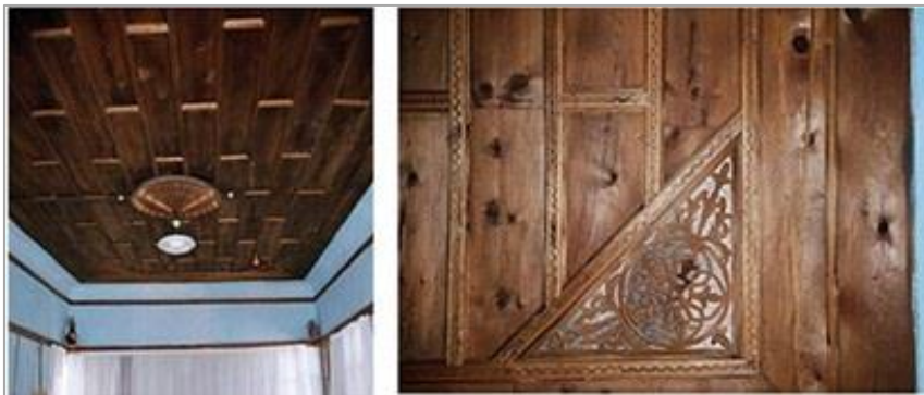
Resim 4.3. Divriği’de bulunan Muratoğlu Evi Yaz odası, çökürtme tavanlı ve bezeme altı kumaş kaplamalı tavan detayları (Ünlüdil’in tez çalışmasından alınarak yazar tarafından düzenlenmiştir (Ünlüdil, 2005)
