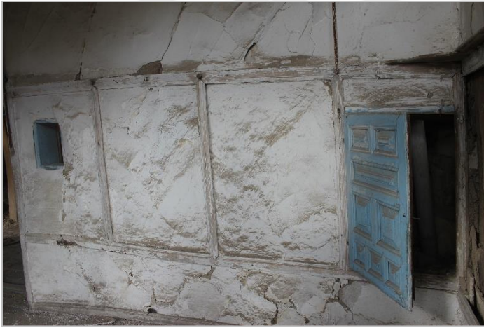
Resim 3.20. Z02 mahali kuzey duvarı
