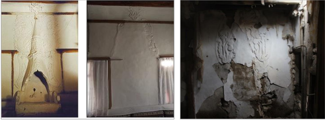
Resim 4.2. Sırasıyla; Sancaktar Evi alçı yaşmaklı ocak örneği, Osman Ağa Evi kapatılan ocak örneği (Ünlüdil, 2005 ve Çelimli, 2016), Z04 mahali kapatılan ocak izi
