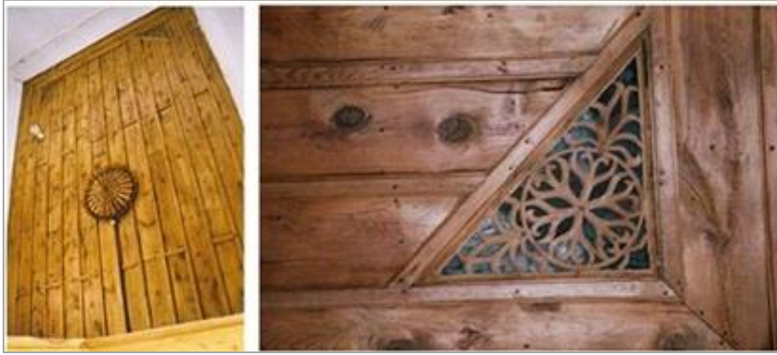
Resim 4.4. Divriği’de bulunan Uzungil Evi çökürtme tavanlı ve bezeme altı kumaş kaplamalı tavan detayı (Ünlüdil’in tez çalışmasından alınarak yazar tarafından düzenlenmiştir (Ünlüdil, 2005).
