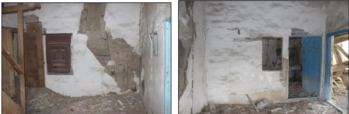
Resim 3.56. Sırasıyla; Z01 mahalinin doğu duvarı ve 102 nolu mahal batı duvarı
