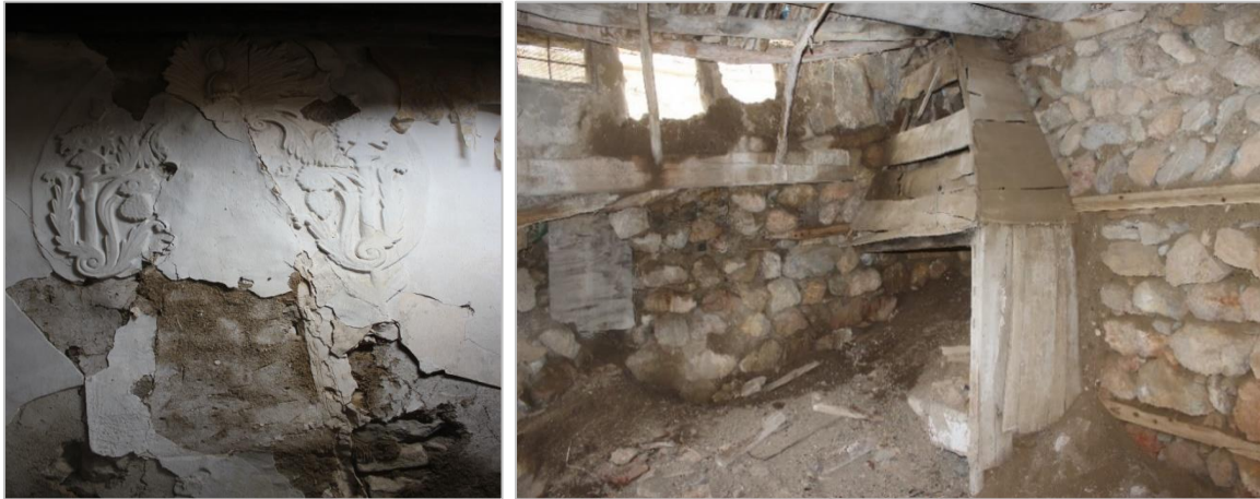
Resim 3.68. Z04 Mahali kapatılan alçı bezemeli ve ahşap ocak detayları
