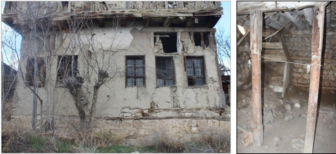
Resim 3.54. Sırasıyla; Taş su basman, Z04 mahali taş duvar ve ahşap kolonları
