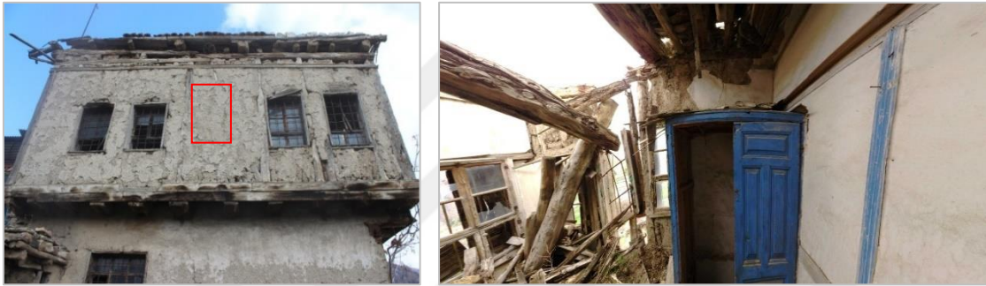
Resim 3.83. 103 nolu mahal iptal edilen pencere yeri ve çağlık dolap detayı
