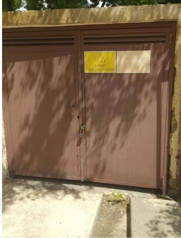
Fotoğraf 3.17. Otel 2'nin geçici atık depolama alanı 1 (1. geçici atık depolama alanı)
