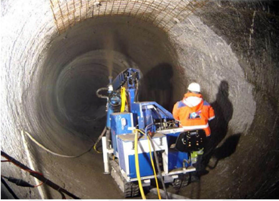
Şekil 3.7 Püskürtme beton uygulaması
