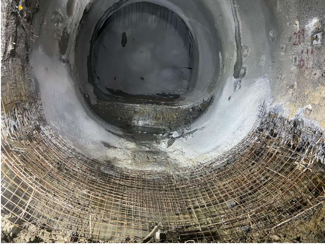
Şekil 3.8 Hasır çelikleri yerleştirilmiş püskürtme beton için hazır tünel
