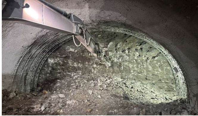
Şekil 3.4 Kazıcı ile zeminin kazılması işlemi
