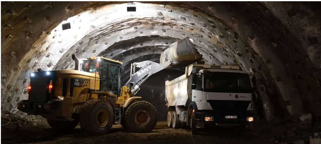
řekil 3.6 Tnelden ıkan malzemeyi kamyonu ykleyen loader
