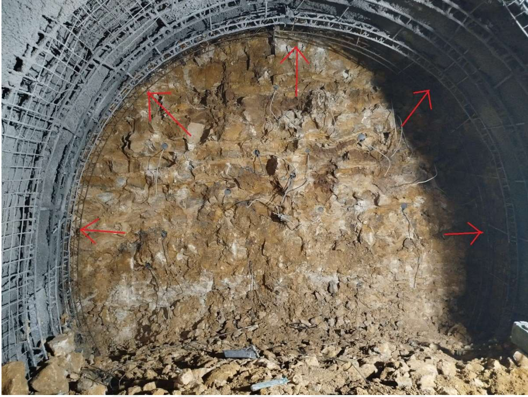
Şekil 3.11 İksası yerleştirilmiş tünel kesiti
