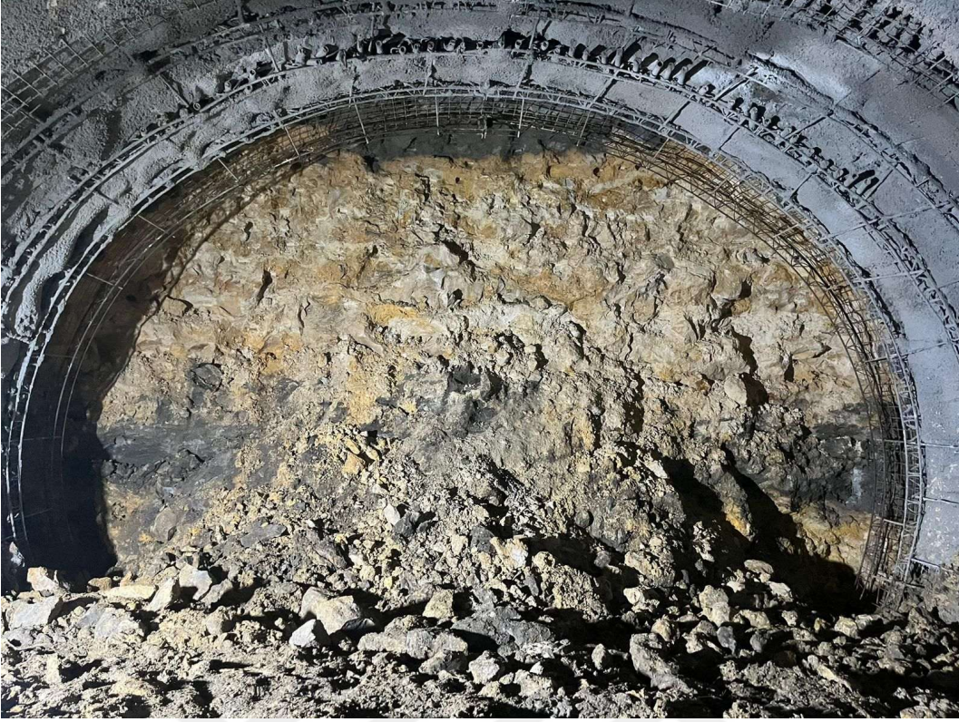
Şekil 3.13 Süren montajı yapılmış tünel
