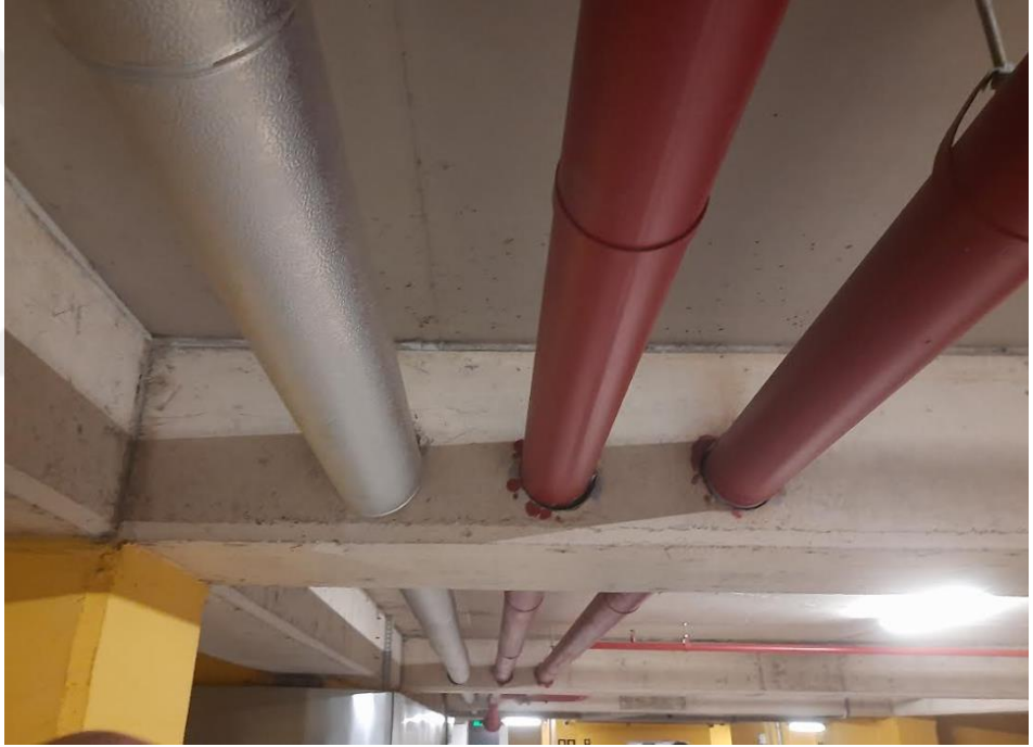
Şekil 1.2. Gövde boşluğuna sahip kirişler
