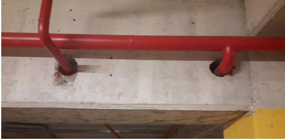
Şekil 1.1. Uygulamada karşılaşılan boşluklu kirişler
