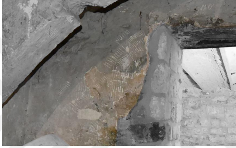
Şekil 4.10 : Osmanlı Bankası Gümüş Deposu İzleri, (Çatal, 2023)
