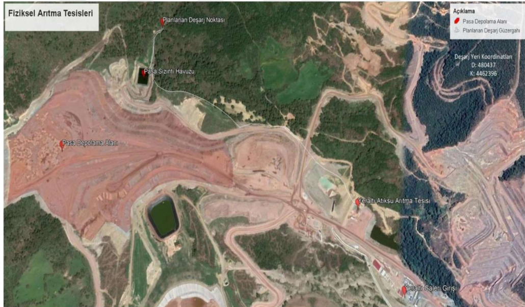
Şekil 3.3. Arıtma tesisleri genel görünüm.
