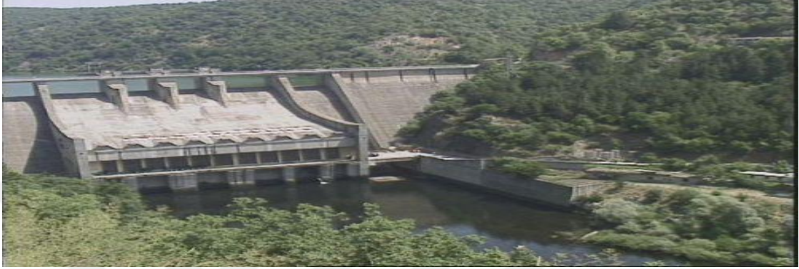
Resim 11. Ortaköy Barajı Gövdesi
