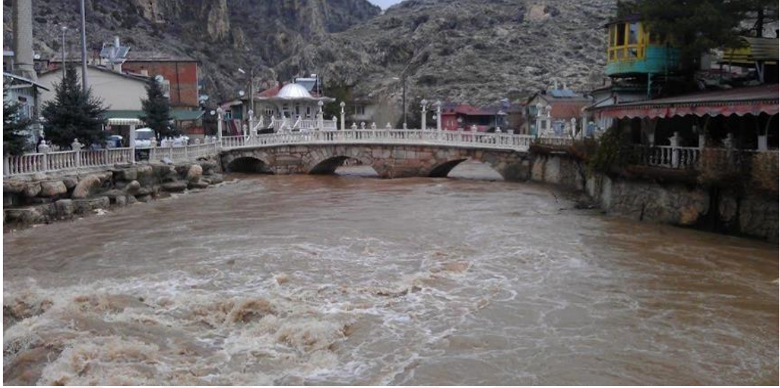
Resim 5. Bozkır İlçesinde Yer Alan Daraltılmış Tarihi Köprü
