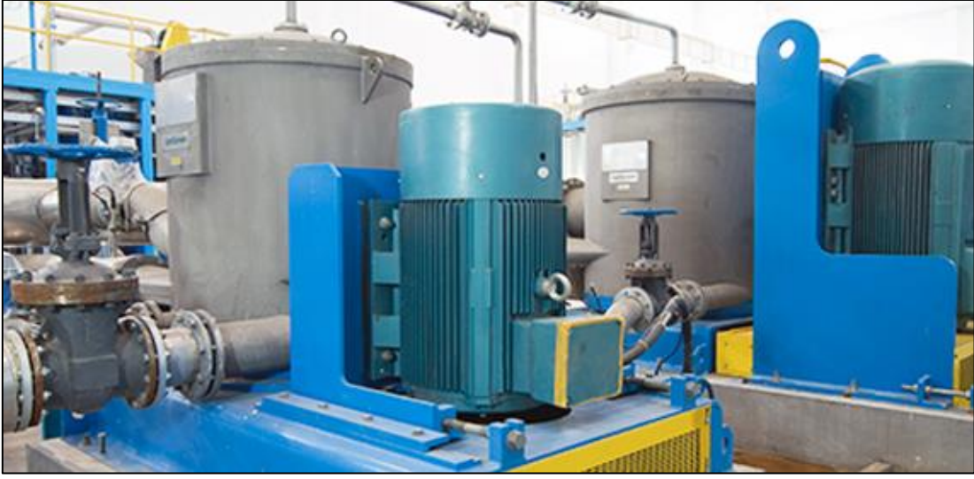
Şekil 2.8. Hamur temizleme eleği genel görünümü (URL-1)
