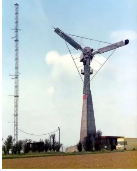
Şekil 2.5. Kompozit kanat kullanılan ilk rüzgâr türbini [18]
