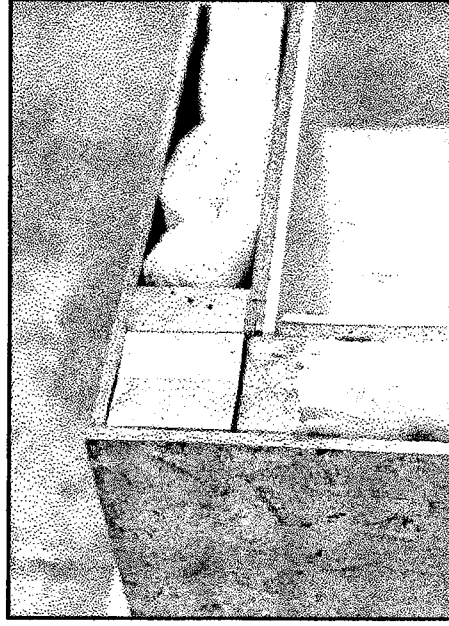
Şekil 3.17. Masif ahşap taşıyıcılı ahşap panelleri köşe birleşimi
