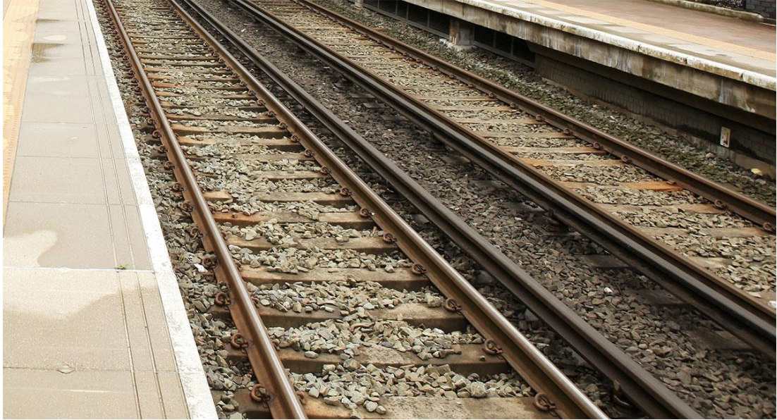
Şekil 1.3 : Üçüncü ray olarak bilinen daha koyu renkli yükseltilmiş raylar 750 volt DC elektrik taşır [2].
