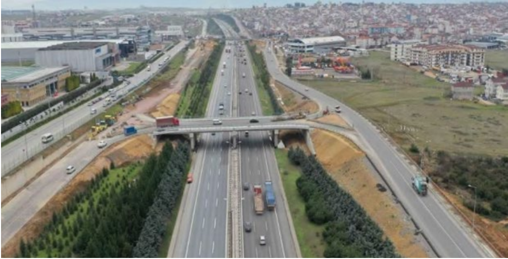
Şekil 2.1 Bağlantı yolu-1 köprüsü
