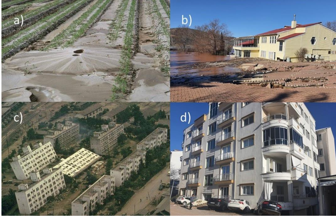
Resim 2.1. Sıvılaşma hasar görünüşleri: a) kum kaynaması b) yanal yayılma ve yatay deformasyon c) taşıma gücü yenilmesi (Agaiby ve Ahmed, 2016) d) düşey deformasyon
