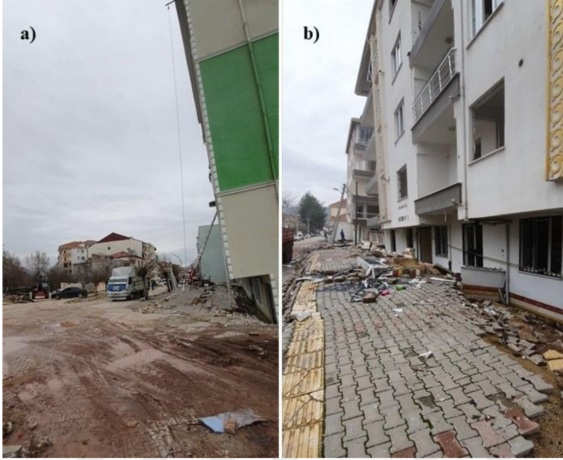
Resim 7.9. Sıvılaşma sonrası yapı etrafı kabarma görünümleri: a) A, B ve C blok yerleşimi; b) D-E-F-G blok yerleşimi
