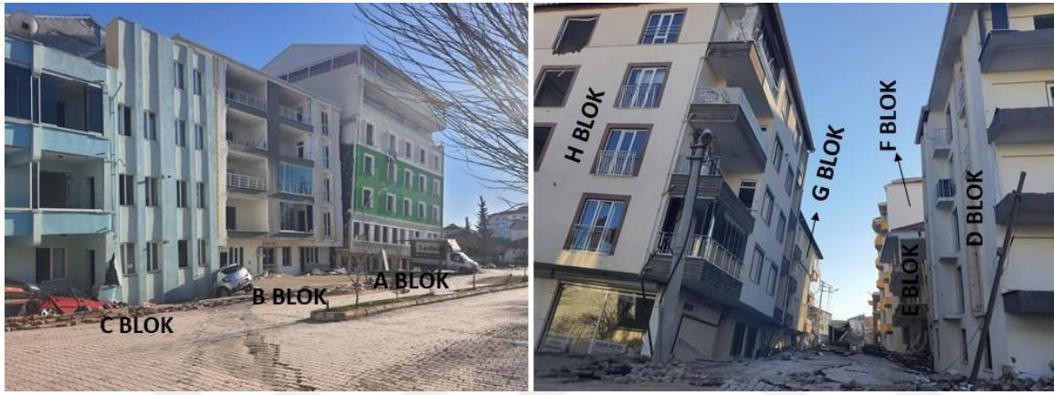
Resim 3.4. 2 Nolu İnceleme Alanı yapı hasar görüntüleri
