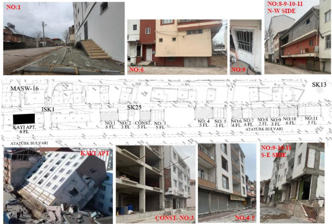
Resim 3.2. I No'lu inceleme alanı yerleşim planı ve yapı hasar görüntüleri
