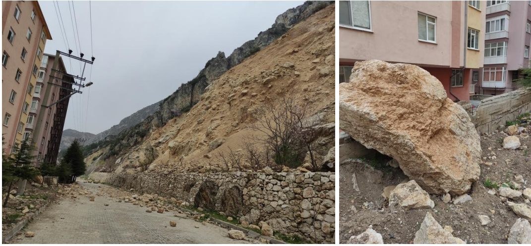
Şekil 4.Yoğun konutların bulunduğu alana düşen kaya blokların görünüşleri
