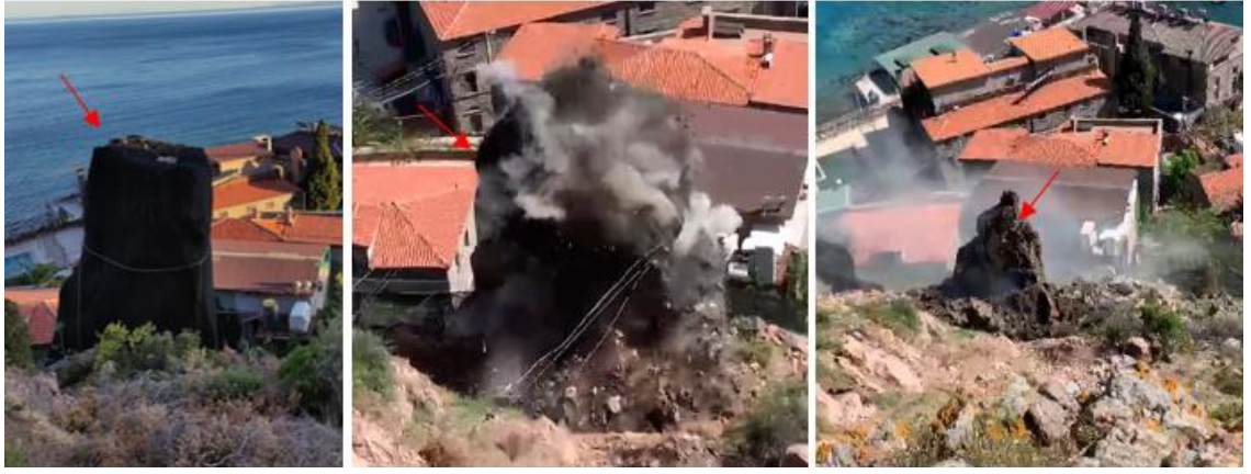
Şekil 7. Assos Antik Liman kaya ıslahı çalışmalarında tam kontrollü kaya kırım uygulamasına ait görseller (Nasery vd., 2024a)
