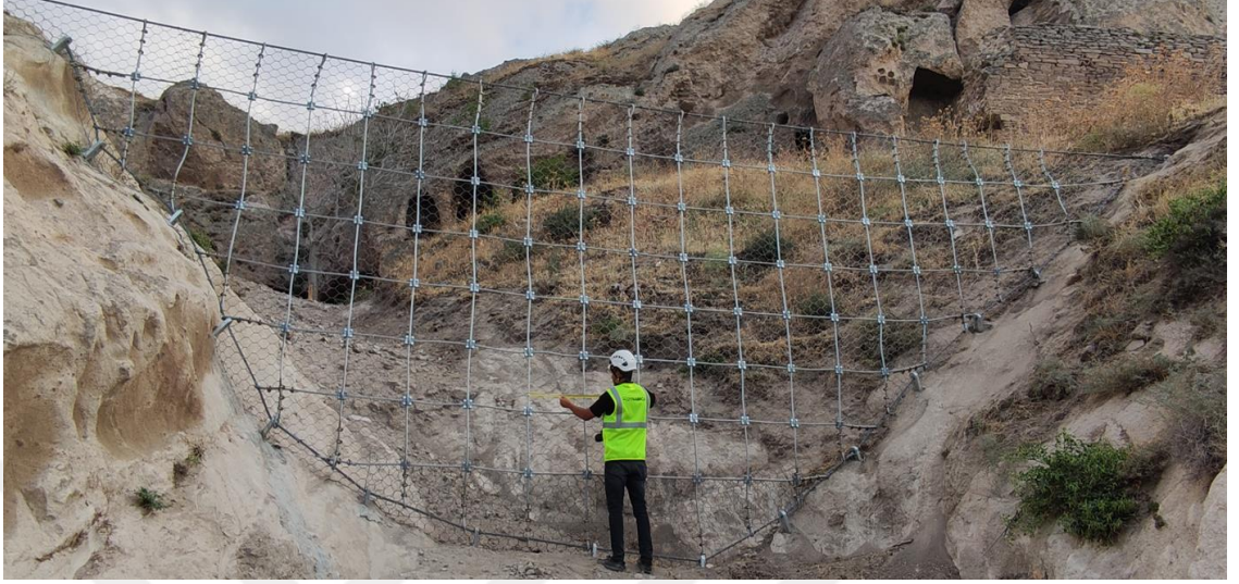
Şekil 13. Sahada uygulanmış oluk bariyer görünümü
