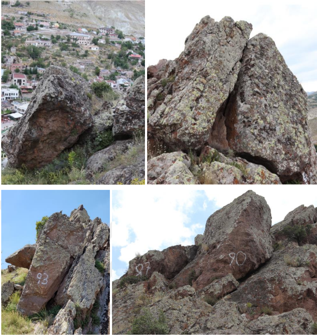
Şekil 153. Kontrollü kaya kırımı uygulaması kapsamında kırılarak yamaçtan uzaklaştırılacak riskli blokların görünüşleri
