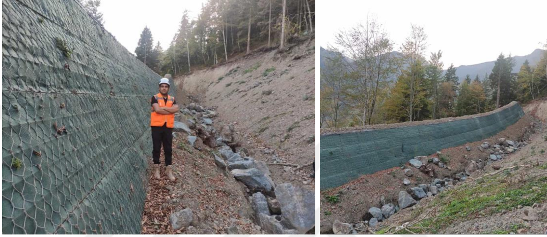
Şekil 15. Kaya tutucu toprakarme bariyer görünümü
