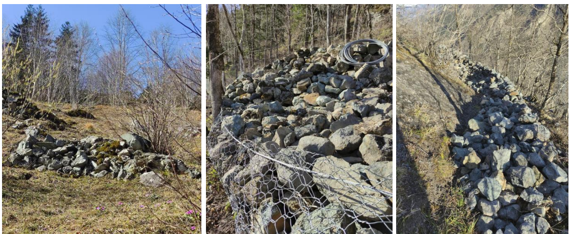
Şekil 9. Kaya ıslahı çalışmalarında yapılan kırım ve istiflenme görünümleri
