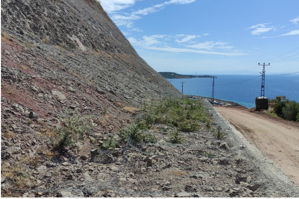
Şekil 14. Çelik tel ağ ile örtüleme örneği
