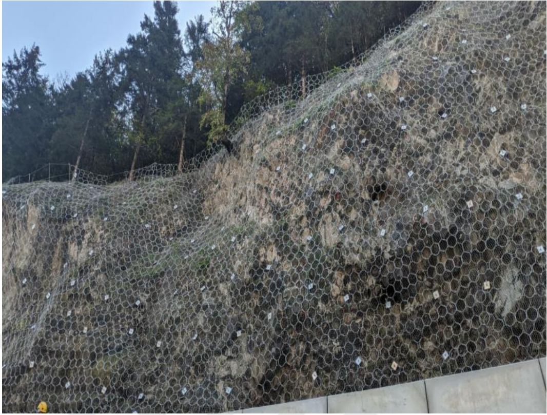
Şekil 10. Halka ağ sistemiyle yamaç kaplanması (URL-4)
