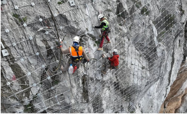
Şekil 11. Güçlendirilmiş kombine ağ ile kaya sabitlenmesi örnek görseli
