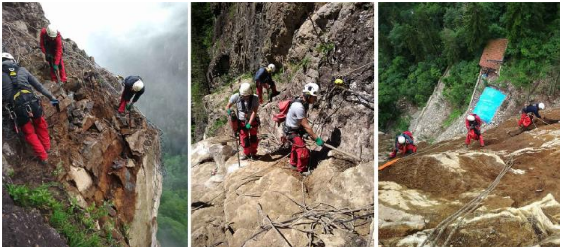
Şekil 8. Sümela Manastırı ıslah çalışmalarında sıçrama kontrollü kaya kırım uygulaması (Nasery vd., 2023)
