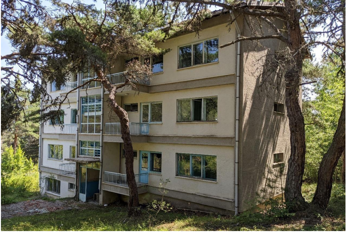
Şekil 3.32. Lojmanın ön cephesinden bir fotoğraf.
