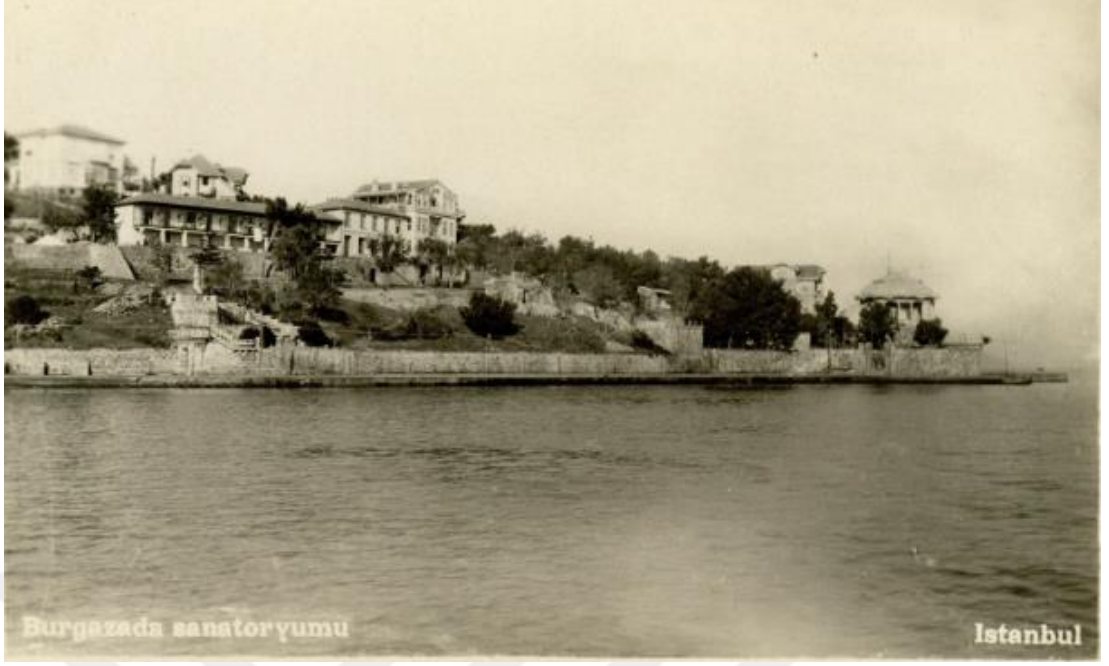
Şekil 2.32. Burgazada Sanatoryumu, denizden görünüşü. (Url: https://archives.saltresearch.org/handle/123456789/123826?locale=tr , erişim 2024)
