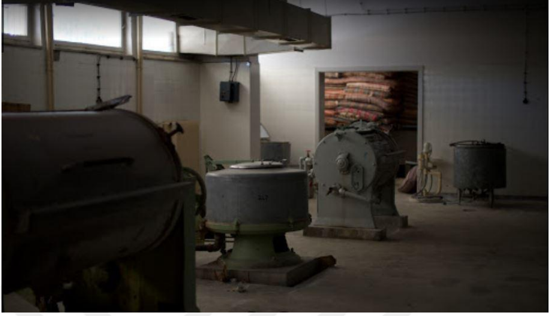
Şekil 3.11. Sanatoryumun I formundaki yapının bodrum kat deposu.
