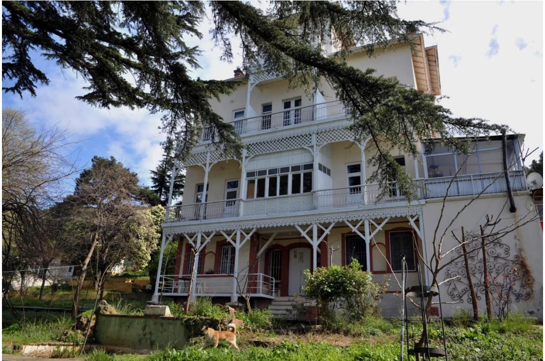
Şekil 2.41. Büyükada Sanatoryumu, köşk binası.
