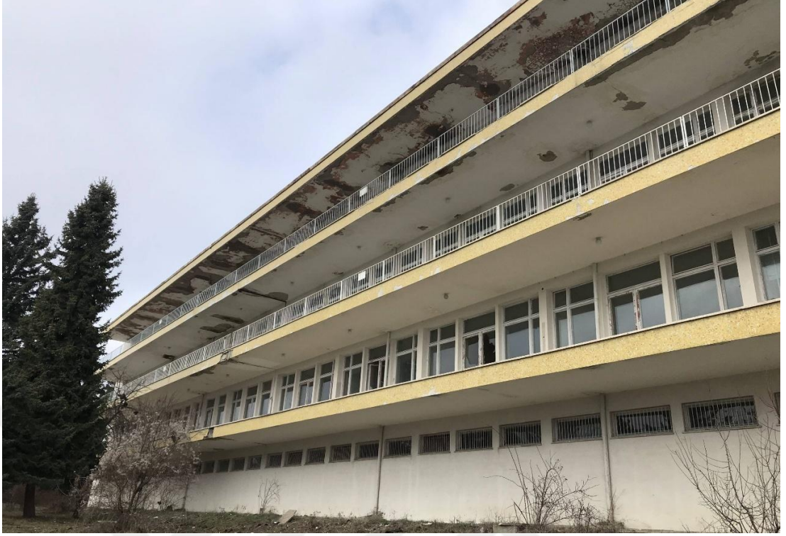
Şekil 3.9. Ballıdağ Sanatoryumu teras cephesi.
