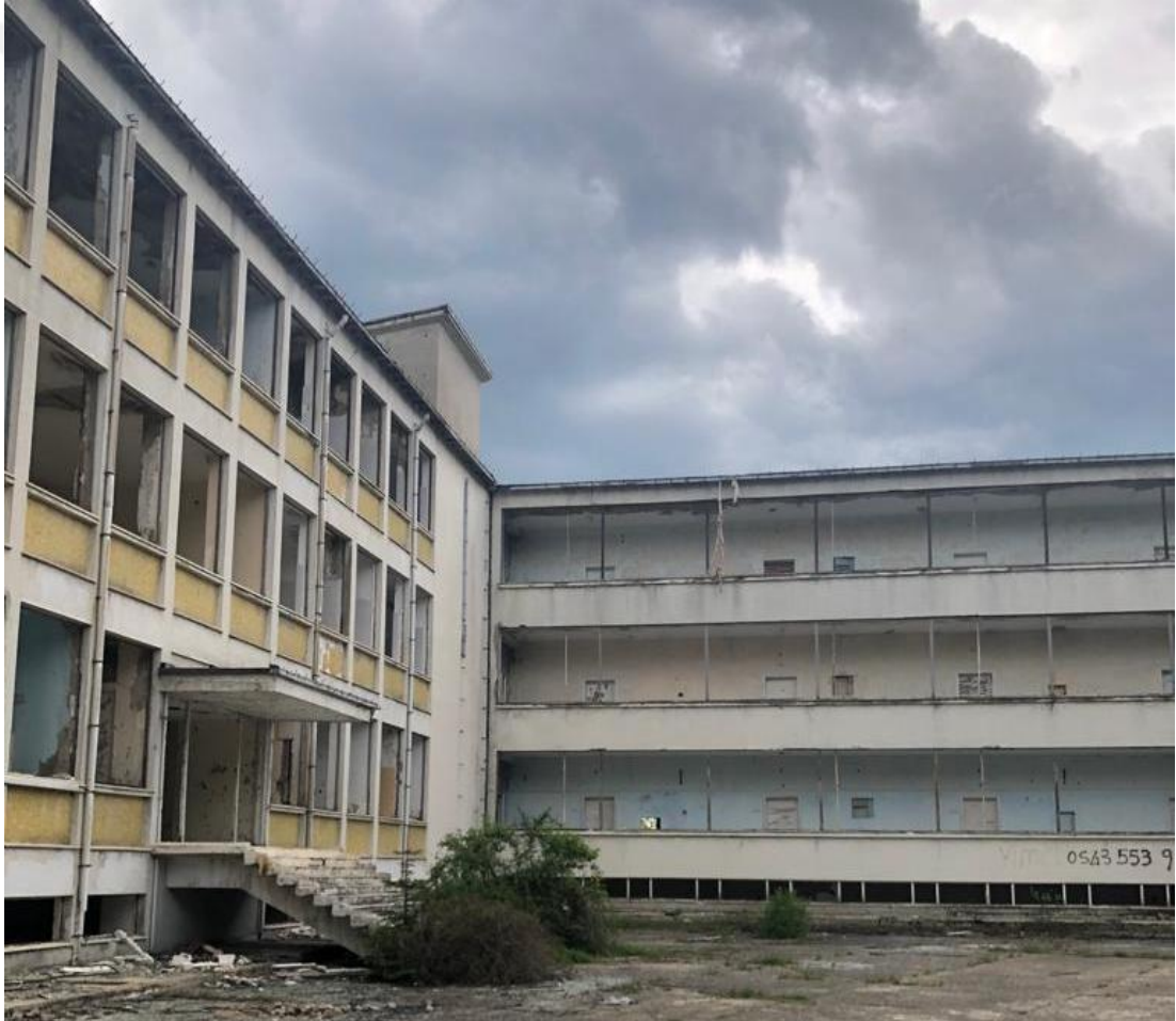
Şekil 3.10. Ballıdağ Sanatoryumu ana yapı L formlu blok ana giriş (AE Mimarlık arşivinden).
