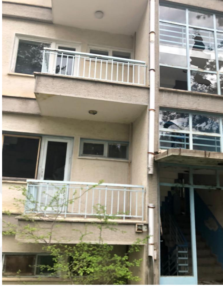
Şekil 3.33. Lojmanın ön cephesinden yakın açıyla çekilmiş bir fotoğraf (AE Mimarlık arşivinden).
