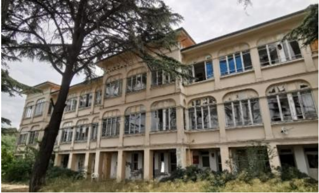
Şekil 2.42. Büyükada Sanatoryumu, ilave betonarme yapı.
