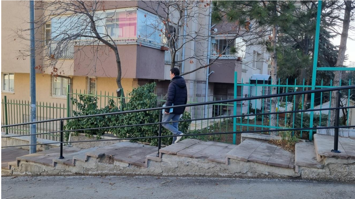
Resim 5.10. Konut sitesi kontrolsüz erişim örneği
