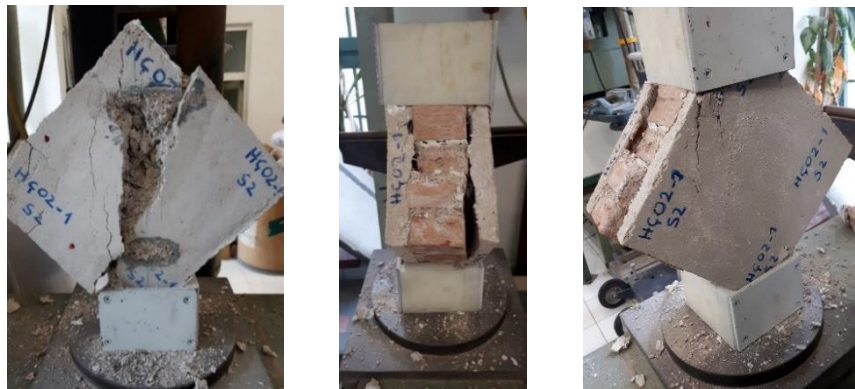
Şekil 6.12 : Çelik hasır donatılı horasan harcı ile çift taraflı güçlendirilen hasarsız model tuğla duvarın göçme şekli.
