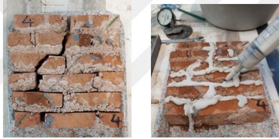
Şekil 5.16 : Hasarlı model tuğla duvarların enjeksiyon harcı ile onarılması.
