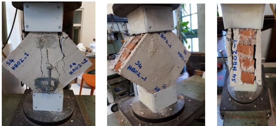
Şekil 6.20 : Bazalt mesh donatılı horasan harcı ile çift taraflı güçlendirilen hasarsız model tuğla duvarın göçme şekli.
