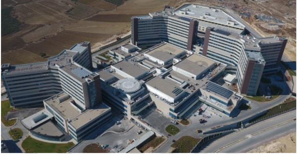
Şekil 7.28. Mersin Şehir Hastanesi görünüm [kaynak: http://bultensaglik.com ].
