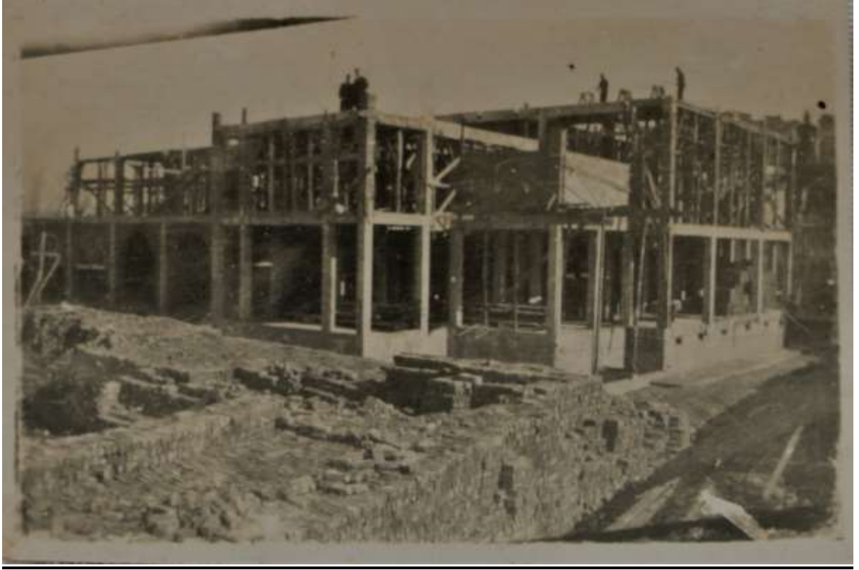
Buz Depoları İnşaatı (F. Bengi Seyyidoğlu Arşivi'nden)
