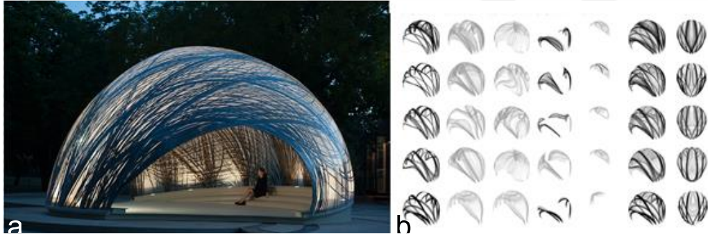
Şekil 2.9: a) ICD/ITKE karbon ve elyaf lif ile tasarlanmış kabuk strüktür 2014-15. b) Lif katmanlarından oluşan sayısal model (Vasey ve diğ, 2015) .
