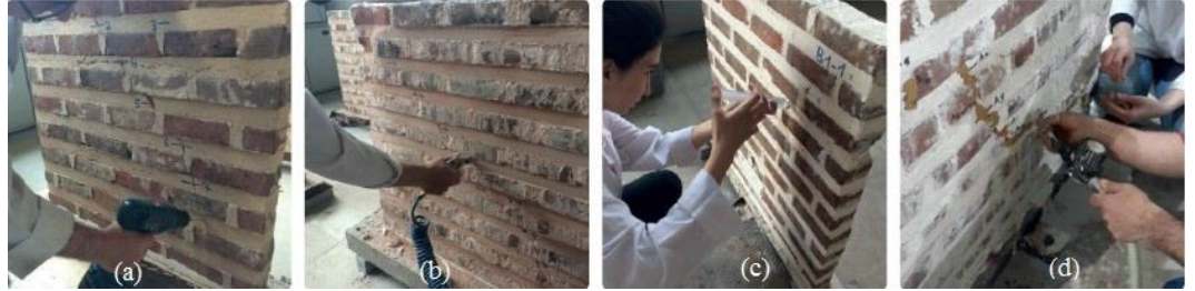
Şekil 4.11 a) Matkapla enjeksiyon yapılacak deliklerin açılması b) Hava ile deliklerin ve çatlakların temizlenmesi c) Temizlenen bölgelerin su ile ıslatılması d) Enjeksiyonun uygulanması (Tarihi Yapılar İçin Deprem Risklerinin Yönetimi Kılavuzu, 2018).
