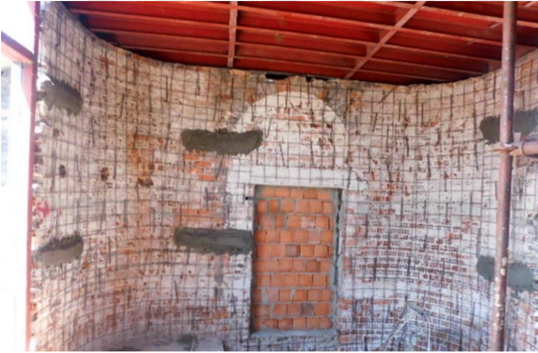
Şekil 4.13 Yığma duvarın güçlendirilmesi (Zemin Araştırma Merkezi LTD., 2018).
