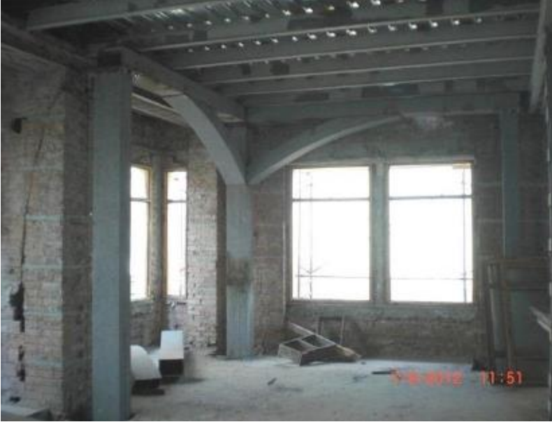
Şekil 4.16 Çelik profillerle güçlendirme (Chamaky, 2014).
