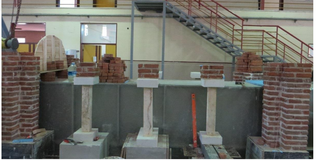
Şekil 6.11 Beden duvarlarının birleştirilmesi ve tuğla örgüsünün kemer başlangıç kotuna çıkarılması.
