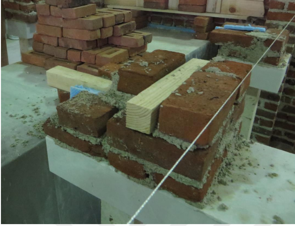
Şekil 6.12 Gergi elemanı için yapıda bırakılan yerler.
