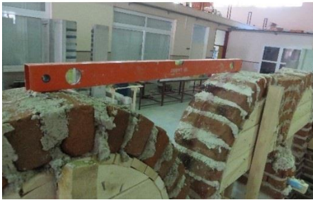
Şekil 6.13 Dış kemer formlarının oluşturulması.
