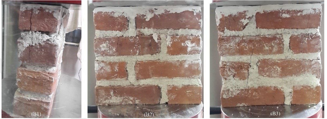
Şekil 6.28 Tek eksenli basınç deneyi altında tuğla duvar (4 sıra) numunelerinin üzerinde oluşan çatlaklar.
