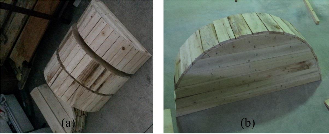
Şekil 6.10 Kemer kalıpları a) Uzun doğrultudaki b) Kısa doğrultudaki.
