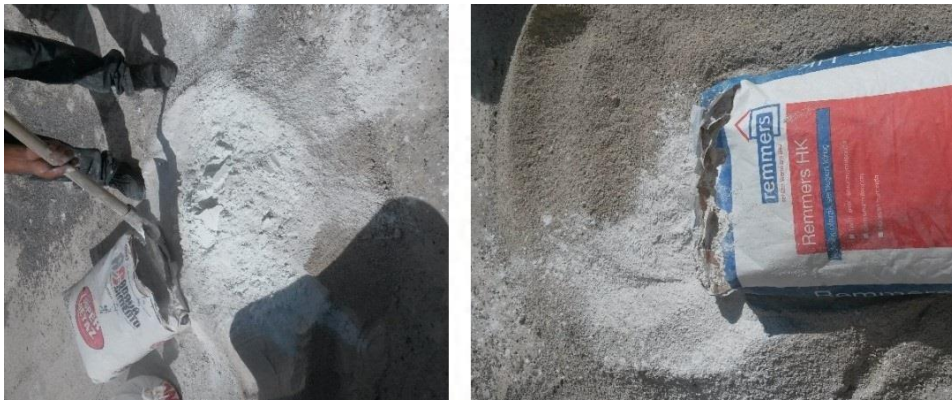
Şekil 6.7 Horasan harcının hazırlanışı.
