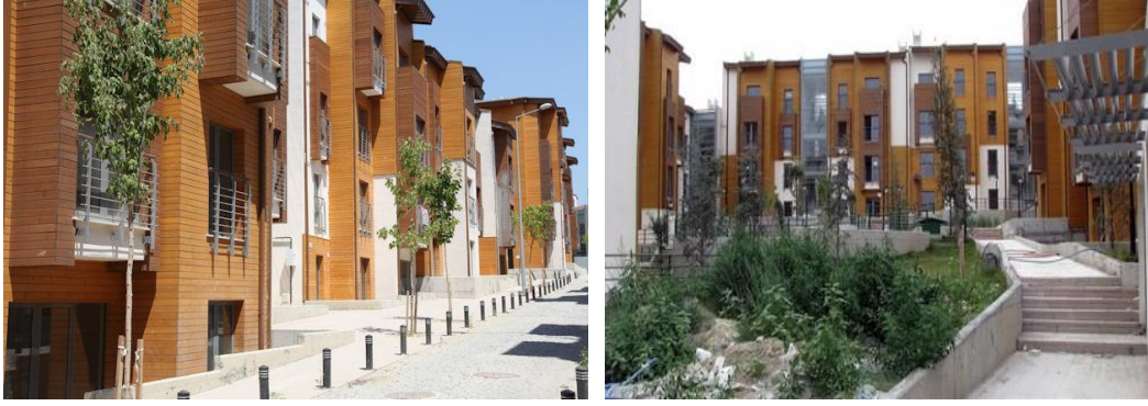
řekil 5.7 Sulukule Kentsel Dnřmnden Sonra Yapılan Yeni Binalar [175]
