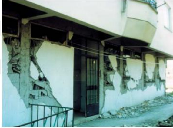
Şekil 2.6. Kısa kolon kırılmasının olmadığı düşük dayanımlı briket dolgu duvarlı bant pencere (1992 Erzincan Depremi) [20]
