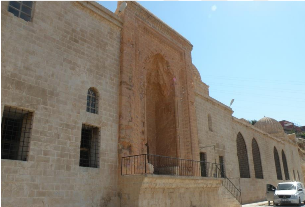
Resim 6.3. Kasımiye Medresesi güney cephesi
