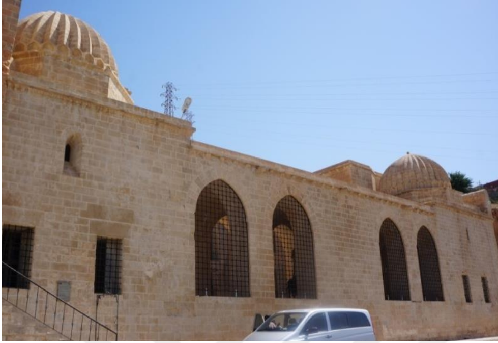
Resim 6.11. Kasımiye Medresesi güney cephesi
