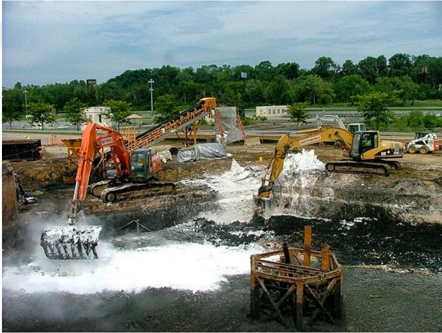
Şekil 2. 9 SAP tozu kullanarak sulu atıklara müdahale edilmesi
