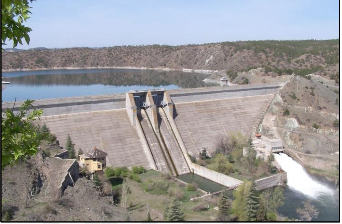
Şekil 3.16 Beton ağırlık baraj örneği, Eskişehir Porsuk Barajı [67].
