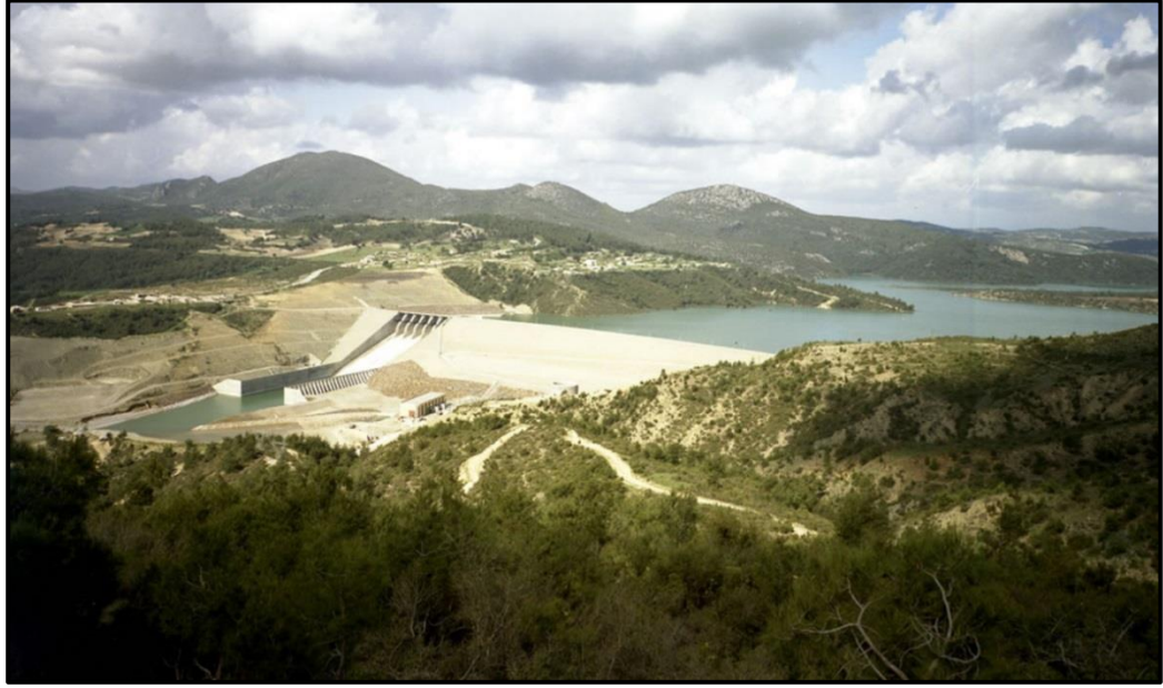
Şekil 3.4 Ülkemizdeki en yüksek homojen dolgu barajlardan Osmaniye Aslantaş Barajı'ndan bir görünüm [55].
