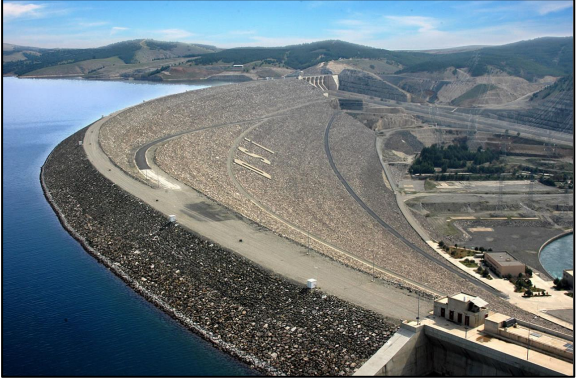
Şekil 3.8 Kil çekirdekli kaya dolgu baraj, Atatürk Barajı [60].
