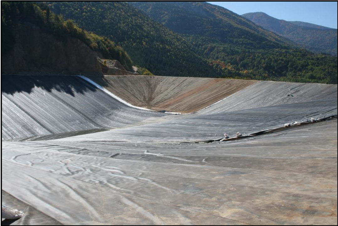
Şekil 3.14 Göl alanı membran kaplı, Bursa-İnegöl Şevketiye Göleti [64].
