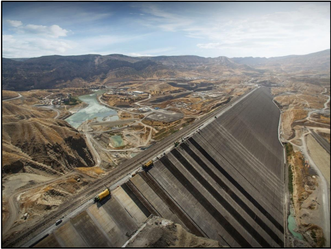
Şekil 3.12 Ön yüzü beton kaplı kaya dolgu, Mardin Ilısu Barajı [63].
