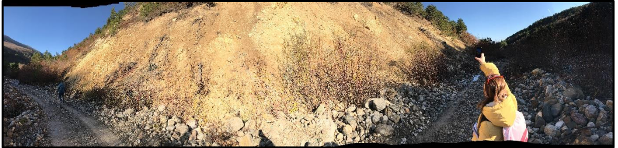
Şekil 6.2 Kozluca Barajı göl alanı sol sahildeki heyelanın görünümü.
