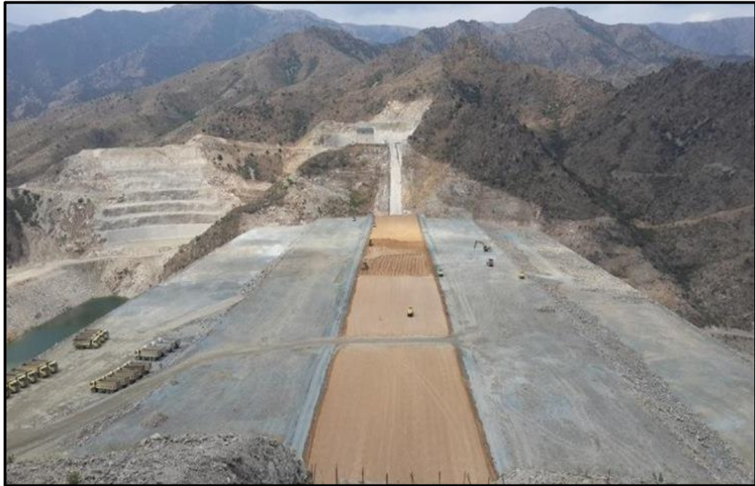
Şekil 3.6 Kil çekirdek yapımından bir görünüm, Azerbaycan-Şemkirçay Barajı ve HES [58].
