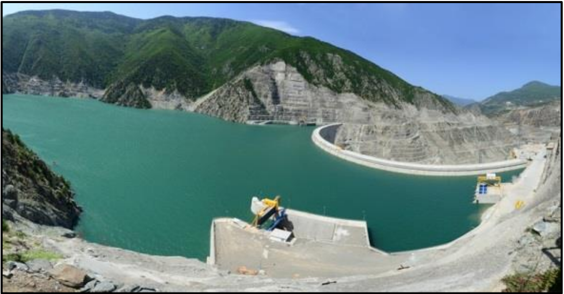
Şekil 3.17 Beton kemer baraj örneği, Artvin-Deriner Barajı [68].
