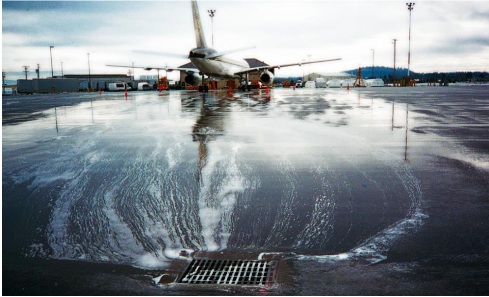
Şekil 2.9: Kullanılmış BÇS’lerin toplandığı ızgara sistemi.
