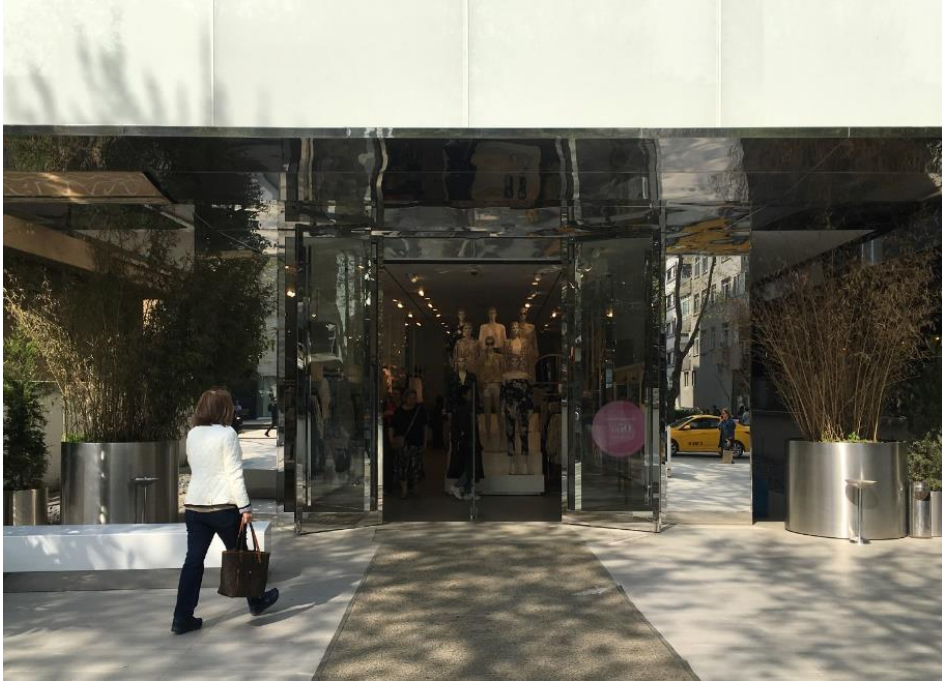
Şekil A.2 : B cephesi fotoğrafı.
