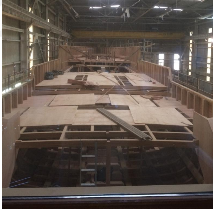
Resim 2. 11 Ahşap konstrüksiyonlu yüzer mekanda 1. Kat oluşumu. Fotoğrafta Tuzla’da bulunan Tansu Yatçılık’ta yapımı süren ahşap tekne bulunmaktadır. Fotoğrafta teknenin üst binalarının oturacağı taban kirişleri yapılmış ve üzerlerine marin kontrplaklar koyulmuştur. Fotoğraf İstanbul Tuzla’da bulunan Tansu Yatçılık’ta çekilmiştir (Yazar arşivi, 2018).
