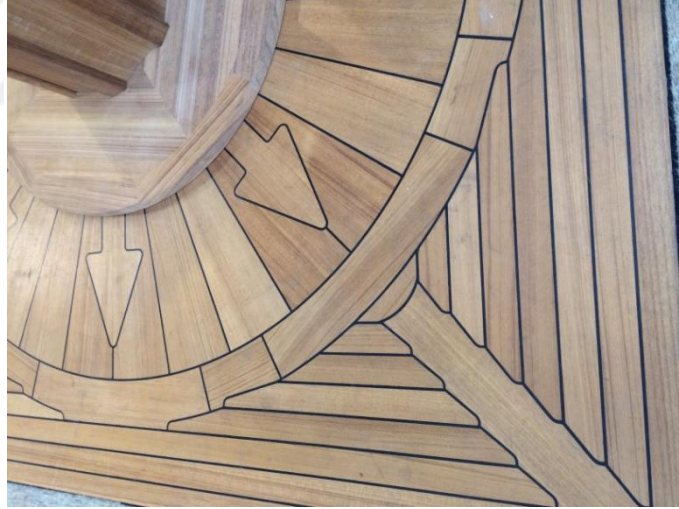
Resim 2. 35 Masif ahşaptan yapılma dekoratif desenli zemin kaplaması. Fotoğraf 2017 yılında Almanya'da düzenlenen boot Düsseldorf fuarında çekilmiştir (Yazar arşivi, 2017).
