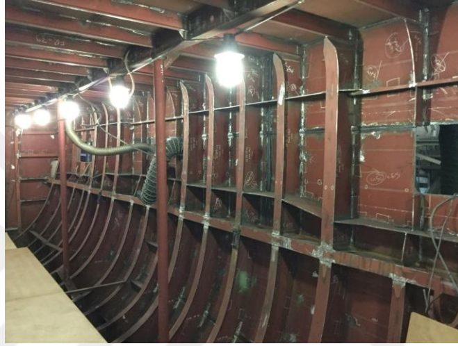
Resim 2. 2 Çelik konstrüksiyonlu yat içten görünüşü. İstanbul Tuzla’da bulunan Ulutaş Tershanesi’nde yapımı süren 43m uzunluğundaki çelik konstrüksiyona sahip yata iç mekandan bakış (Sarıkaya, 2015).
