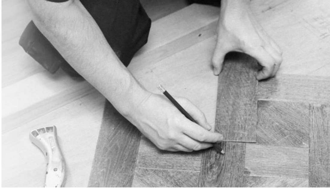
Resim 2. 37 Vinil bazlı karo uygulama aşaması. Fotoğrafta ahşap desene sahip vinil bazlı karolar diyagonal şekilde dizilerek epoksi ile yere sabitlenmektedir (URL 38).
