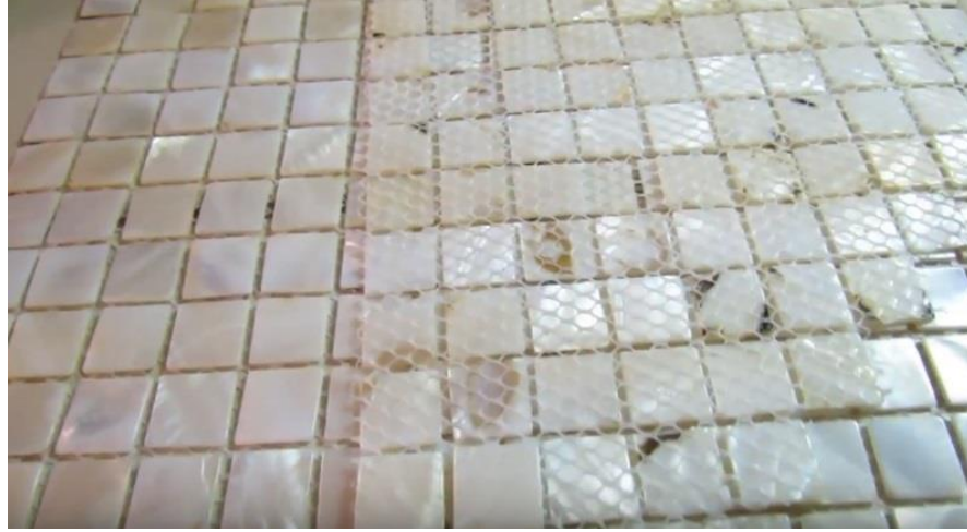
Resim 2. 46 İnci ve deniz kabuğu mozaikleri. Fotoğrafta görüleceği üzere inci ve deniz kabuğu mozaiklerini birleştirmek amacıyla arka kısmında, elyaf örgü destek olarak kullanılmıştır (URL 49).
