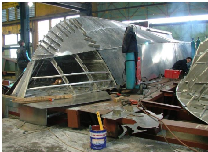
Resim 2. 3 Alüminyum konstrüksiyonlu yat yapım aşaması. Metal konstrüksiyon yat yapımında alüminyum konstrüksiyonlu iskelet strüktür üzeri alüminyum saclarla kaplanarak konstrüksiyon oluşum aşaması. Alüminyum sacların form alması açısından üst kısmında geçici olarak yerleştirilen kalıplar bulunmaktadır (URL 11).
