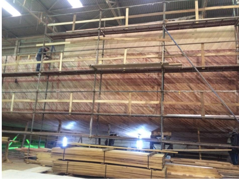
Resim 2. 9 Armuz sistemli gövde. Armuz sistemi uygulanarak oluşturulan 3 katmanlı ahşap konstrüksiyondaki ikinci kaplama katına ait fotoğraf. Fotoğrafta görüleceği üzere ilk kat ve ikinci kattaki çıtalar birbirlerine zıt diyagonellerle döşenmiştir. Fotoğraf İstanbul Tuzla’da bulunan Tansu Yatçılık’ta çekilmiştir (Yazar arşivi, 2018).
