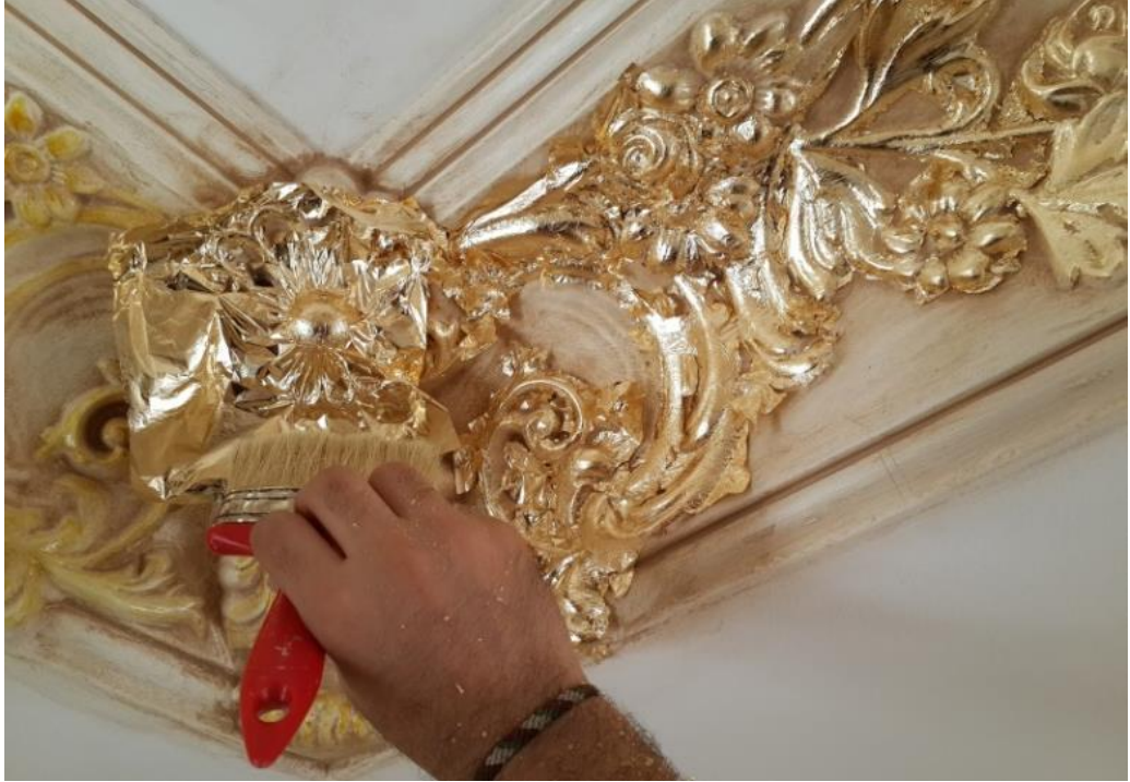
Resim 2. 60 Altın Varak uygulama süreci. Fotoğrafta görüleceği üzere Altın Varak yaprağı fırça yardımıyla yüzeye uygulanmaktadır (URL 64).
